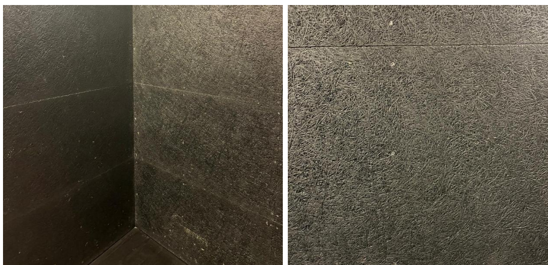
Figura 4.9 – Detalhes dos painéis absorventes de fibras de madeira aplicados nas paredes do palco do Teatro Jordão. [fotos da autora]
