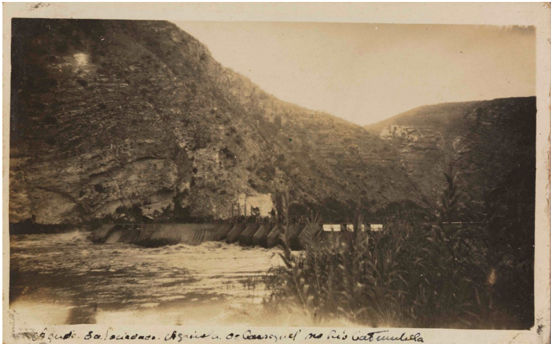
Figura 29: Açude no rio Catumbela para captação e desvio de águas de rega para a cultura da cana do açúcar na Fazenda de Cassequel
