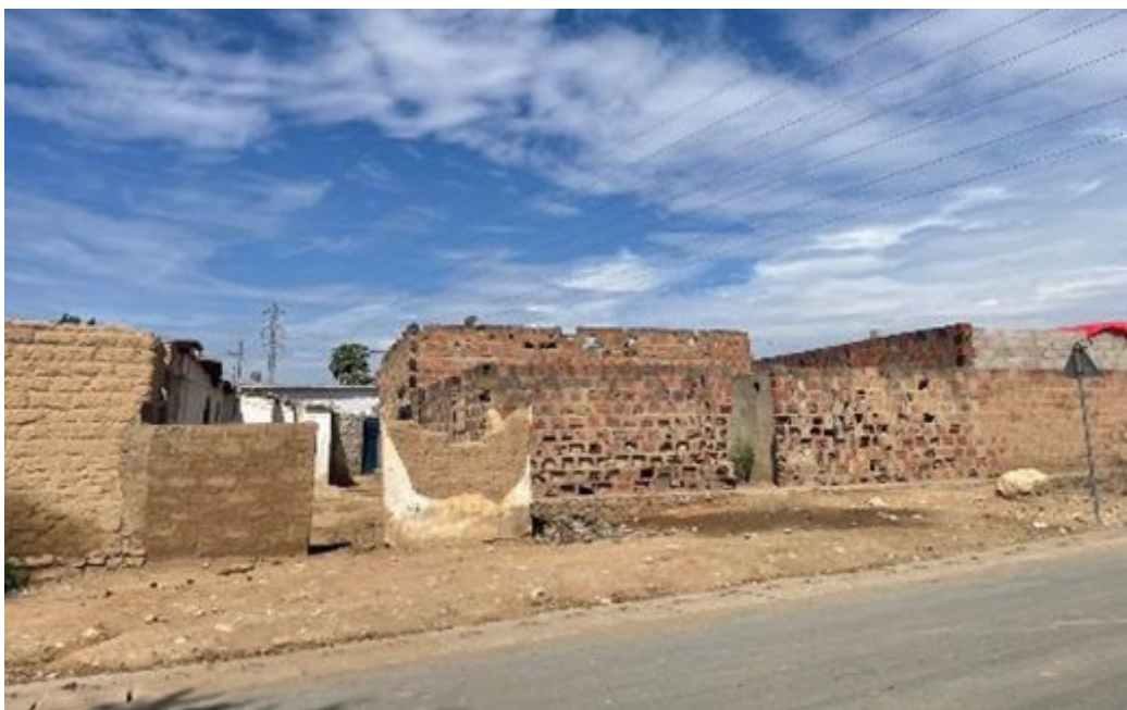
Figura 118: Ruína em tijolo do antigo centro de moagem. Em evidência a proximidade da construção à estrada.
