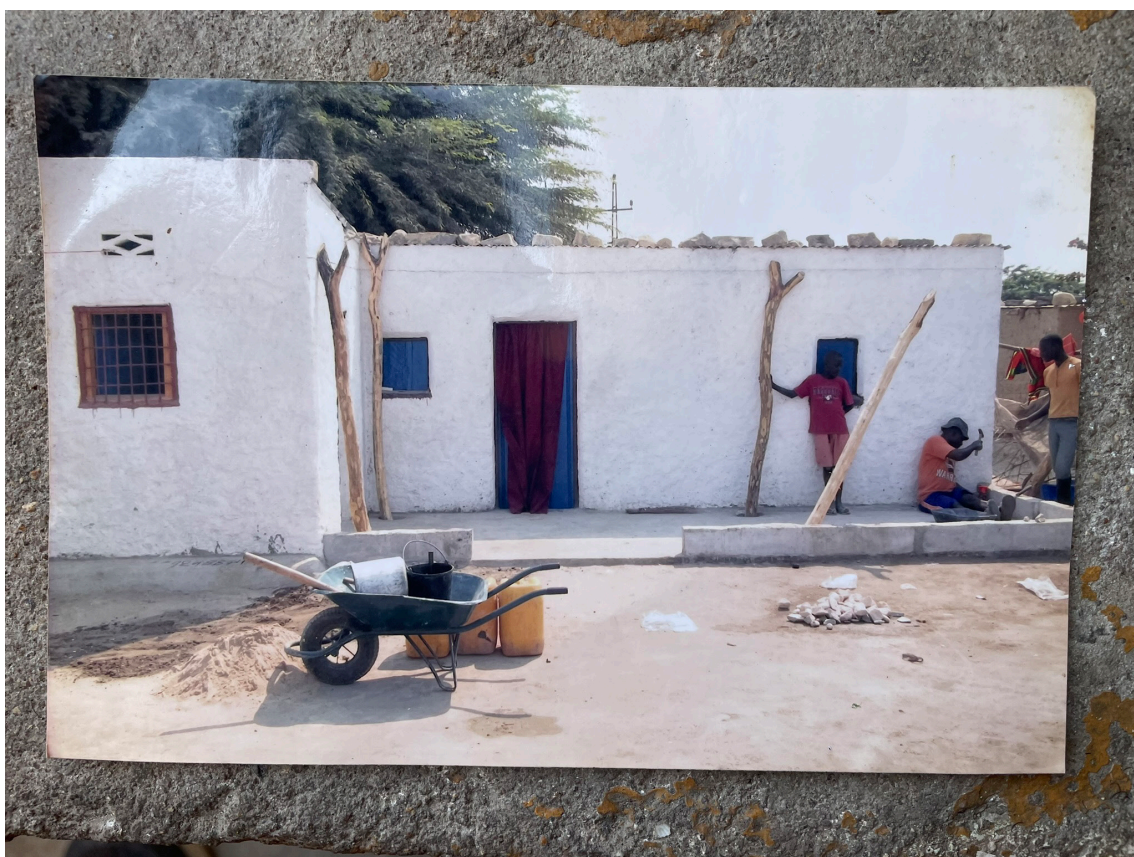
Figura 92: Casa da origem da família, no Chongóroi. À esquerda exemplo de bris du soleil importado à construção posterior.
