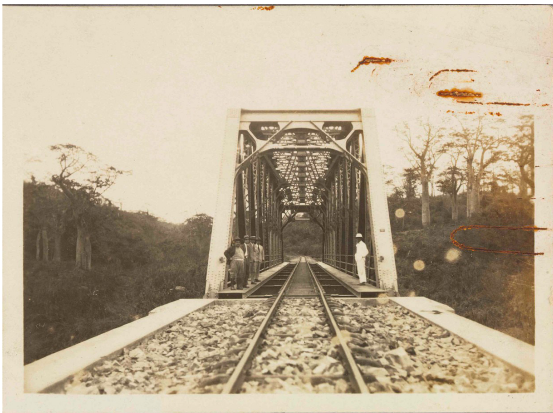
Figura 18: Ponte ferroviária sobre o rio Catumbela, 1920'.
