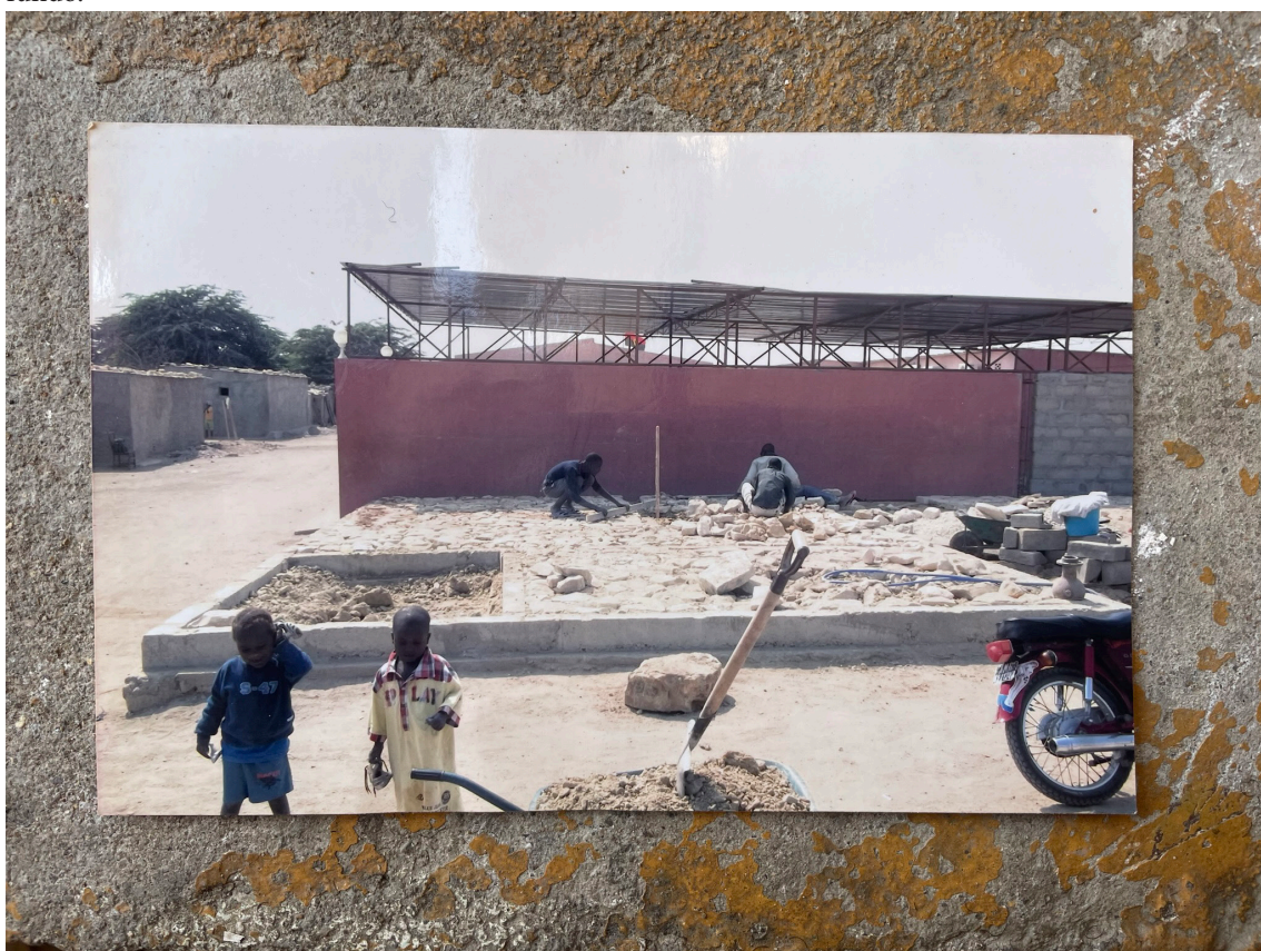
Figura 88: Os caçulas dos irmãos em visita à obra. À direita a motorizada do pai, o seu meio de transporte e negócio.
