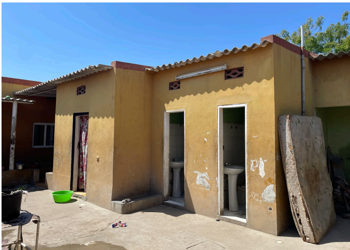
Figura 93: Estado atual de boa conservação da casa.
