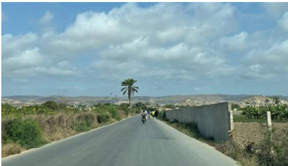
Figura 130: Início do troço asfaltado que atravessa o Gama. Sentido N100 - bairro do Gama.
