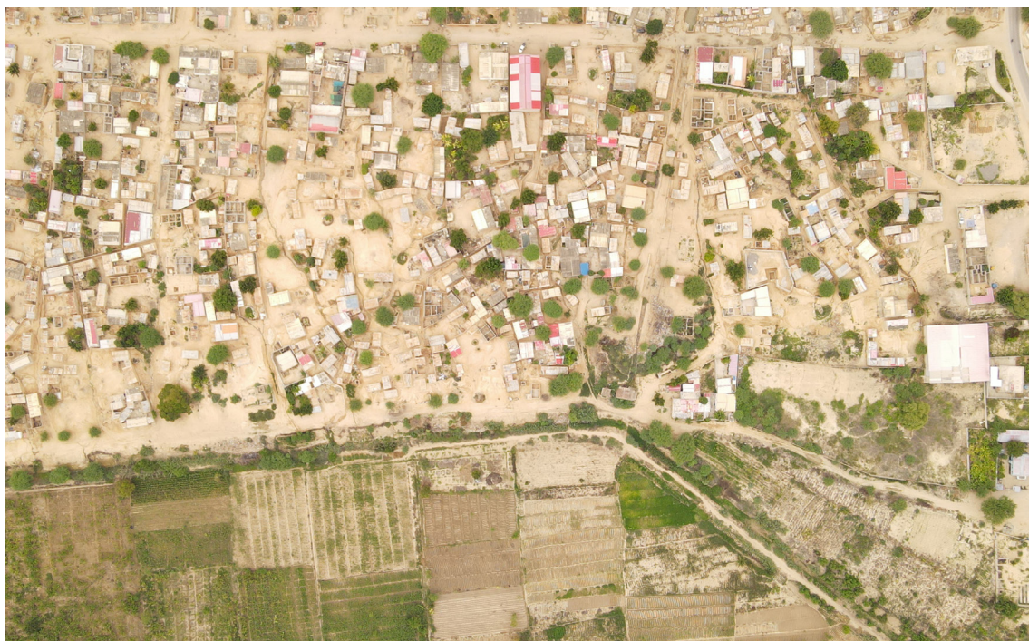
Figura 43, 44: Sistemas de distribuição de água. Em cima, fase primária de nivelamento em paralelo ao rio Catumbela e irrigação das terras agrícolas. Em baixo, presença das lavras e valas, agora sem água na estruturação do bairro do Gama.
