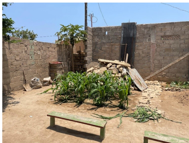
Figura 109,110,111: (De cima para baixo) Forno de lenha em adobe no quintal do Farias, atendimento à janela-balcão no exterior do quintal do Sr. Catumbela, horta no quintal de D. Maria (Gama).
