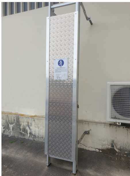
Figura 3.6: Acesso às coberturas numa U.I.
