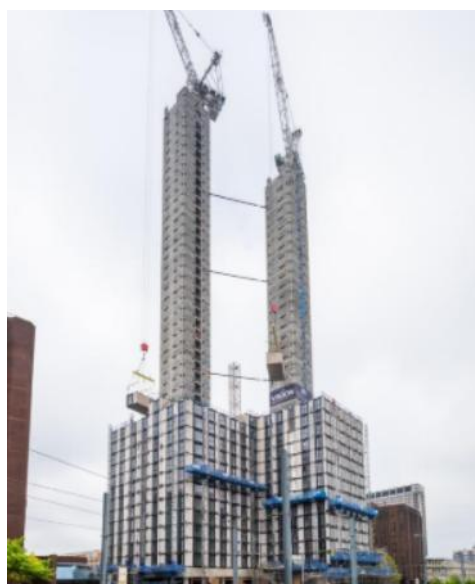
Figura 2 - Instalação de módulos na construção da Croydon Tower (Thai et al., 2020)
