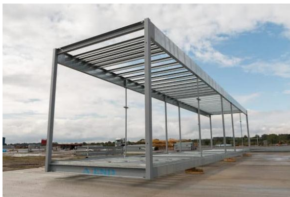
Figura 6 – Construção modular em aço: módulo (PF Modular, 2021)
