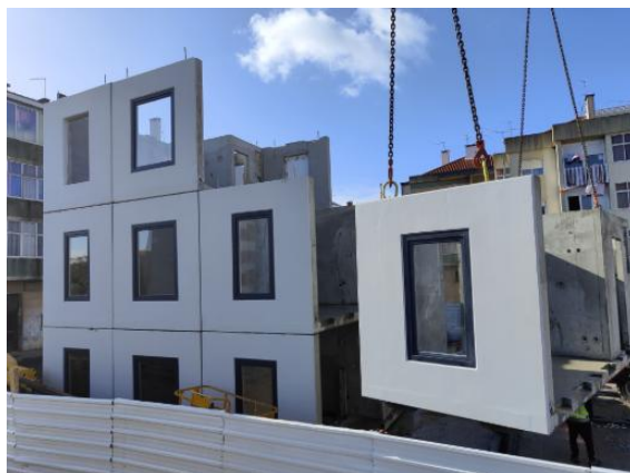
Figura 4 – Construção modular em betão: montagem dos módulos (DDN Gestão de Projetos, s.d)
