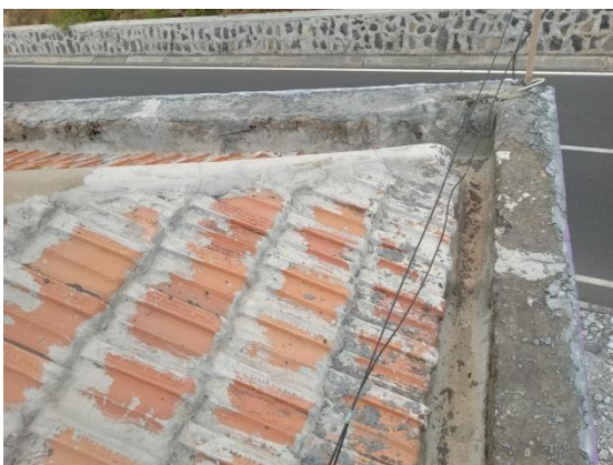
Figura 29: Captação da água da chuva pela cobertura das casas na ilha do Fogo, Cabo Verde
