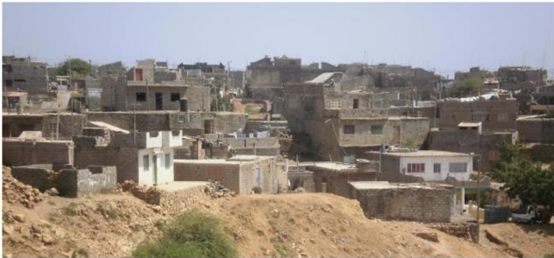
Figura 19: Habitação no bairro de Achada Eugénio Lima feitos a partir de blocos de cimento assentes em argamassa de cimento e areia sem acabamento exterior
