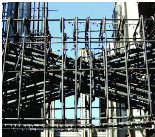
Figura 12 – Representação de armaduras diagonais em obra
