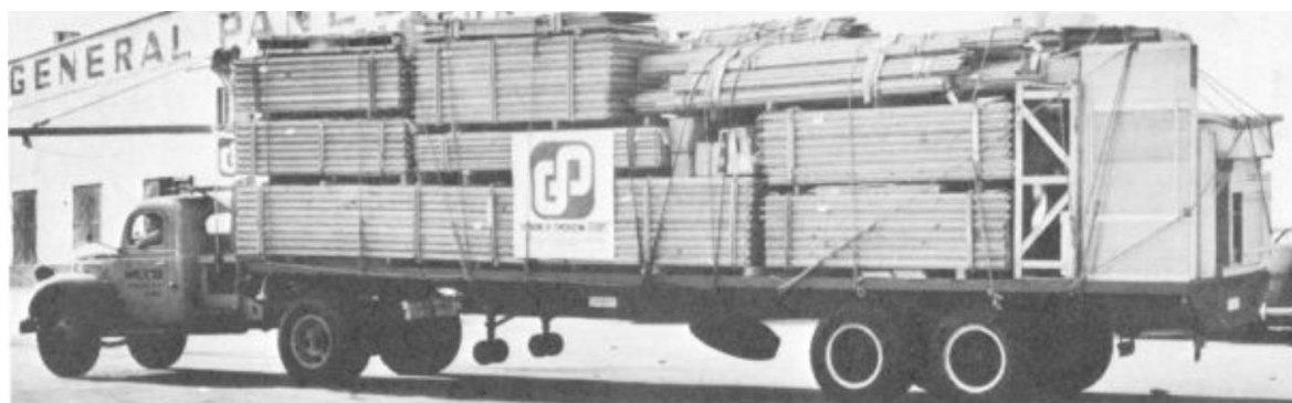
Figura 14 – Sistema Packed House , desenvolvido por Gropius e Wachsmann, concebido para transporte em formato flat-pack por camião [13].
