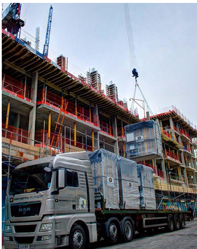
Figura 13 - Transporte e instalação de uma unidade modular de casa de banho [36].
