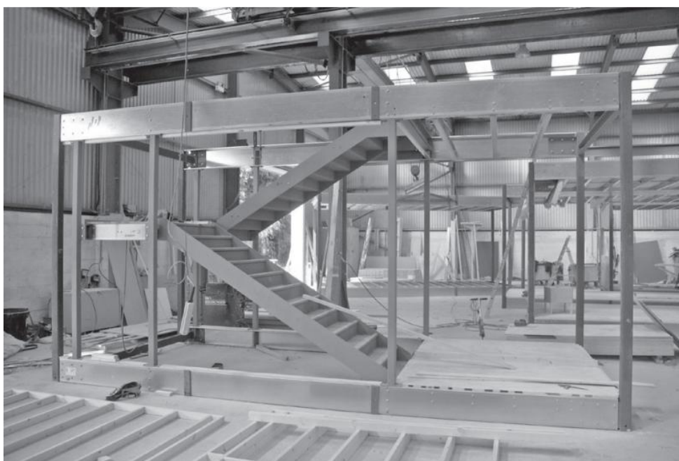
Figura 9 - Módulo de escadas em processo de fabrico em ambiente controlado [20].
