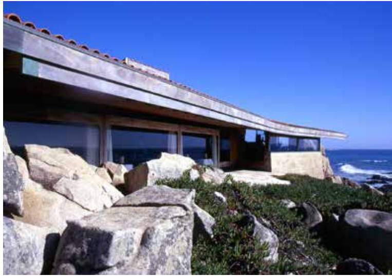
87. Alvaro Siza, Casa de Chá, Leça da Palmeira, 1958- 63 (photo by the author).
