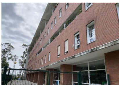
Figura 26 - Fachada tardoz do edifício 4
