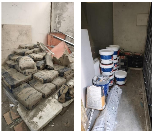
Figura 33 - Armazenamento de materiais em obra
