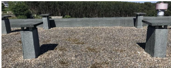
Figura 27 - Cobertura com acabamento final em godo
