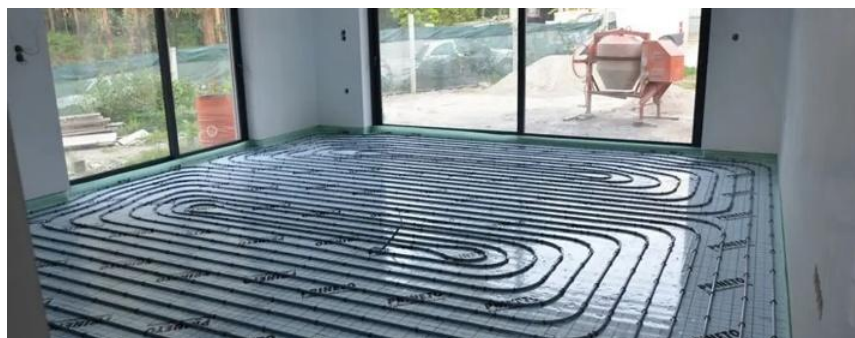
Figura 6 - Pavimento Radiante
