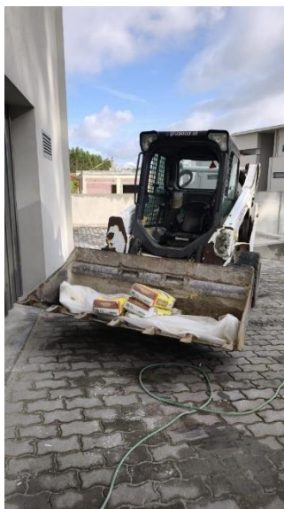
Figura 32 - Bobcat a ser carregado com material
