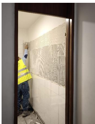
Figura 38 - Trabalhador a colocar cerâmico nas instalações sanitárias
