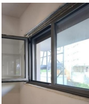
Figura 36 - Exemplo de caixilharia instalada - outro ângulo e tipo de janela diferente
