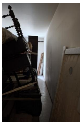
Figura 40 - Espaço restringido devido à permanência de mobiliário e bens dos moradores
