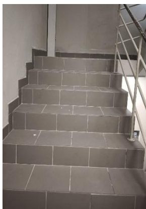
Figura 37 - Caixa de escadas com cerâmicos instalados
