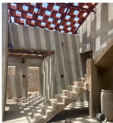
Fig.40- Método Construtivo Estruturado
