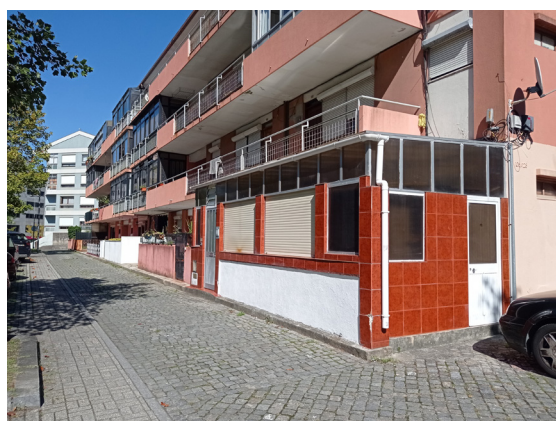
Figura 63. Bairro do Bom Sucesso, Porto
