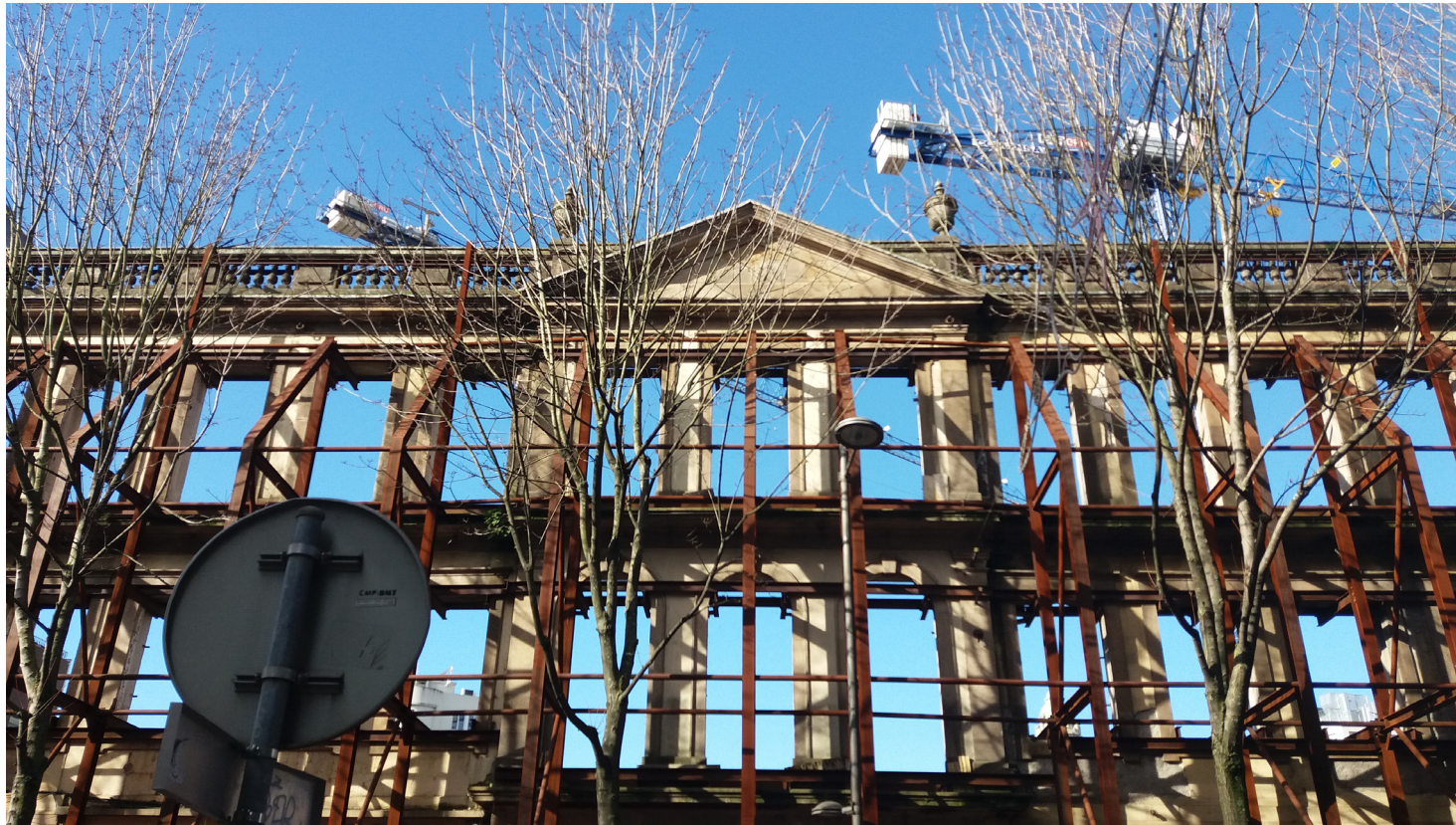
Figura 1. Fachada do quarteirão “Casa Forte”, durante o processo de construção
