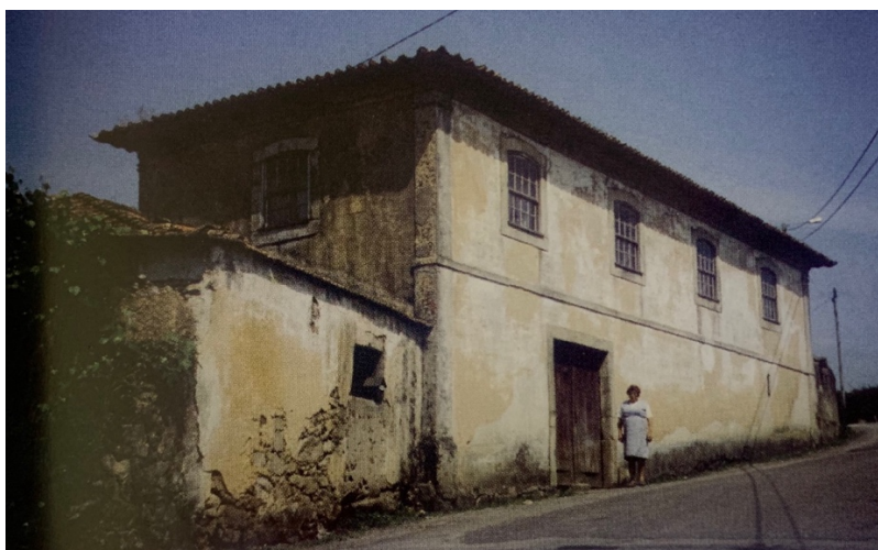
Imagem 11_ Fachada principal da Quinta do Chão do Rio, Rio Meão
