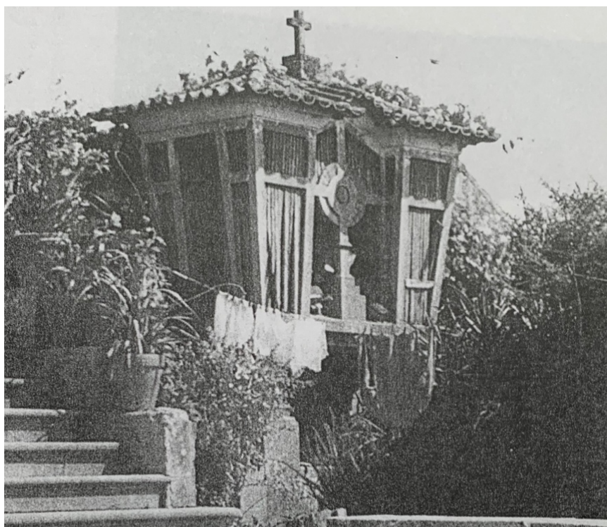
Imagem 7_Espigueiro de uma casa rural em Santa Maria da Feira
