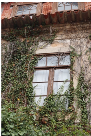
a) Janela da habitação (sul).
