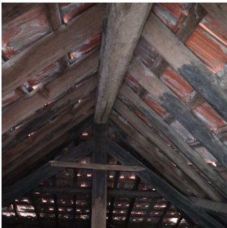
a) Estrutura da cobertura
