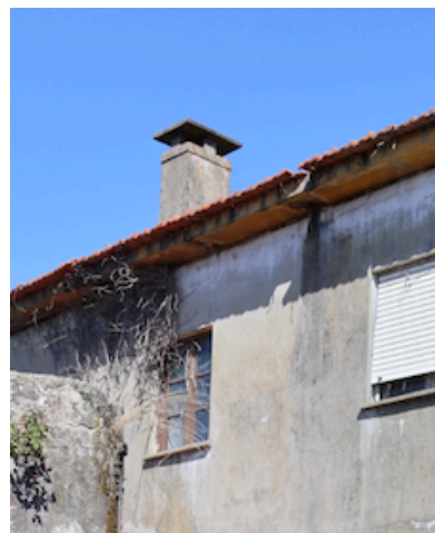
c) Janela da ampliação (Sul)
