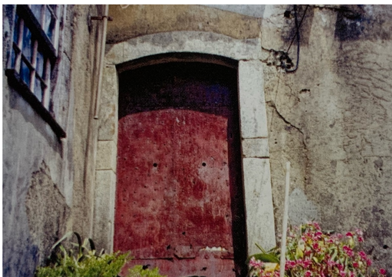
Imagem 15_ Porta de acesso pelo pátio ao 1º andar, onde a chapa grossa recobre a madeira, na Quinta do Chão do Rio, Rio Meão
