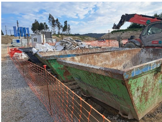
Figura 4.6 – Contentores para separação de RCD (obra exemplo)
