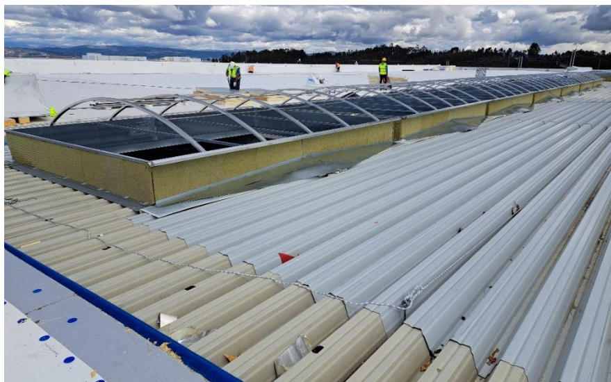
Figura 3.8 – Cobertura e lanternins, edifício da Produção
