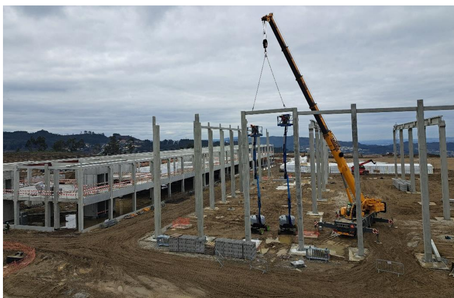
Figura 3.6 – Montagem de vigas pré-fabricadas, edifício Warehouse
