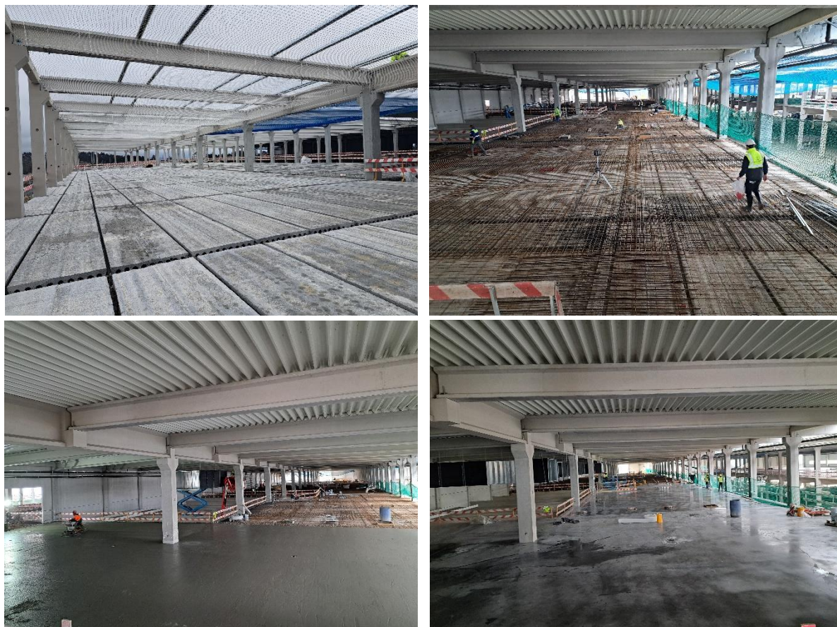
Figura 3.7 – Processo de betonagem das lajes alveolares, edifício da Produção
