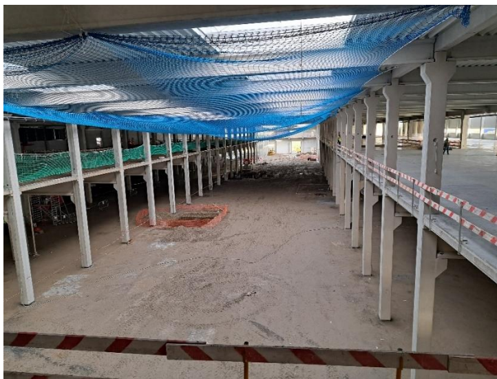
Figura 4.5 – Equipamentos de Proteção Coletiva (obra exemplo)
