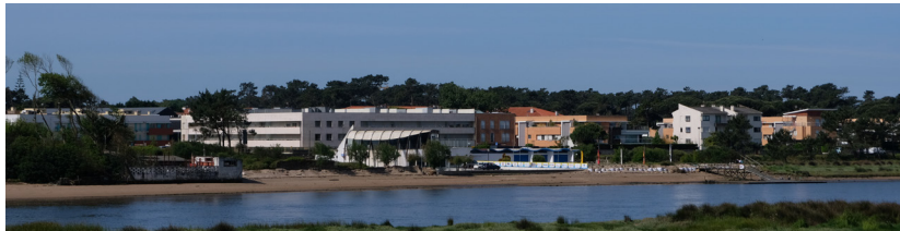
Margem de Fão vista pela ponte, previamente à demolição do Bar do Fôjo
