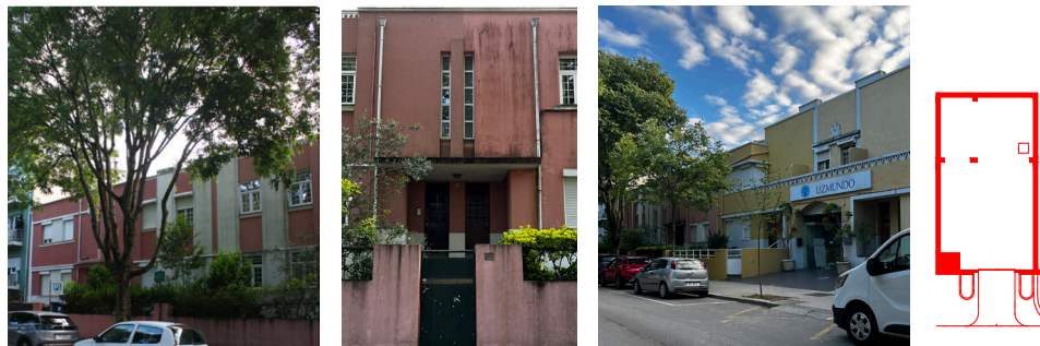
Fig.43 Fotografia do conjunto habitacional na Rua Marques da Silva; Fig.44 Fotografia do conjunto habitacional na Rua Marques da Silva; Fig.45 Fotografia do conjunto habitacional na Rua Marques da Silva; Fig.46 Planta estacionamento, 1994;
