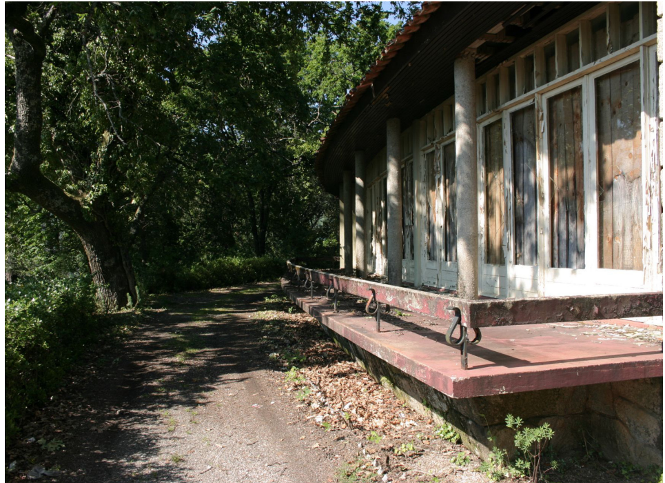
Fig.17 Pousada de Vila a Nova, 1948-1950, construída para a hidroelétrica do Cávado;
