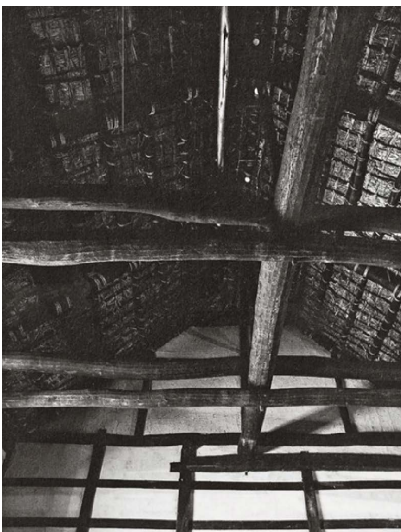
Fig. 45 - Ligações em madeira ( minkas )
