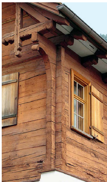
Fig. 37 - detalhe de canto, casa em sistema de toros
