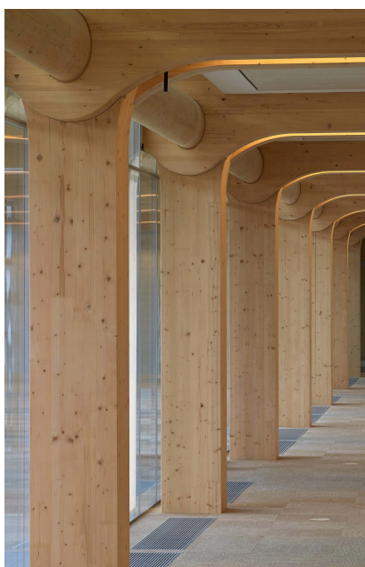
Fig. 56 - Edifício Tamedia, Shigeru Ban (sistema de pilar e viga)
