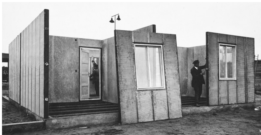
Fig. 14 - Assemblagem da casa pré-fabricada de Walter Gropius, para o concurso The Growing House
