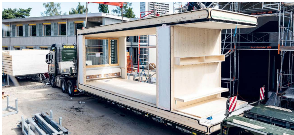
Fig. 53 - Transporte de um módulo pré-fabricado
