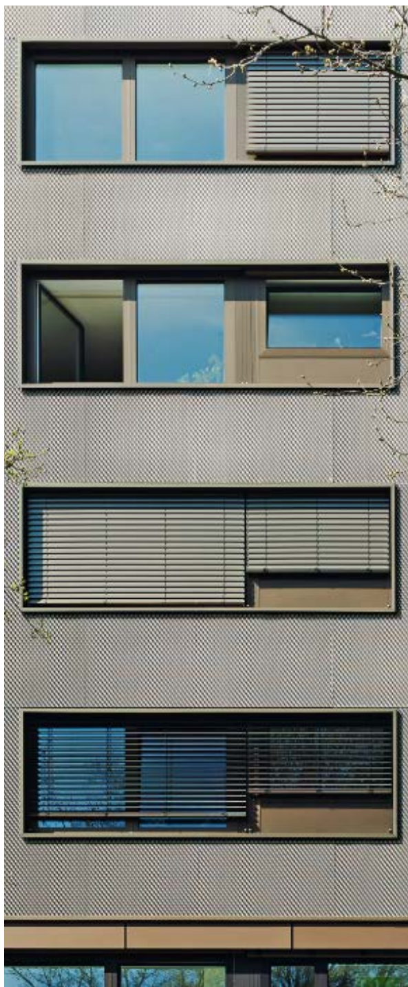
Fig. 81 - Fachada de edifício habitacional em Munique
