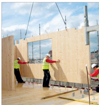
Fig. 54 - Assemblagem de uma parede em madeira maciça (CLT)
