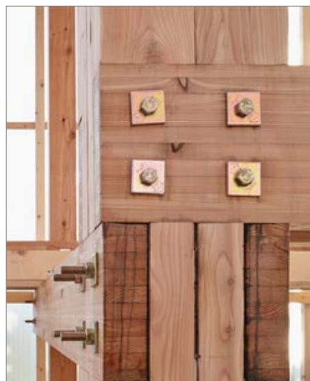
Fig. 64 - Conexão com pernos
