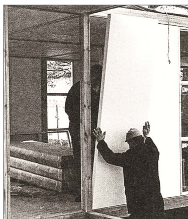
Fig. 48 - Assemblagem do painel modular do sistema Moduli 225
