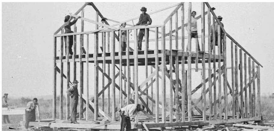
Fig. 34 - Construção em Balloon frame
