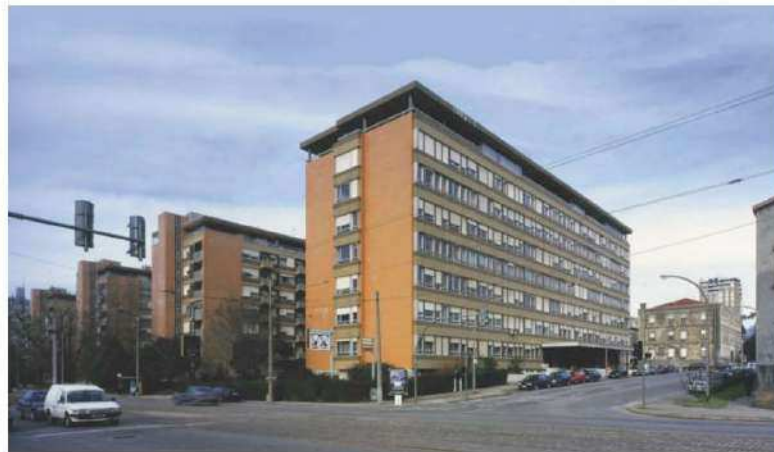
Edifício de escritórios Santo António © Arquivo Agostinho Ricca
