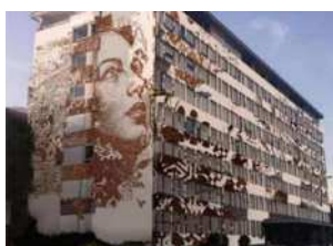
Simulação da obra terminada já com a intervenção de Vhils, usada pelo promotor DR
