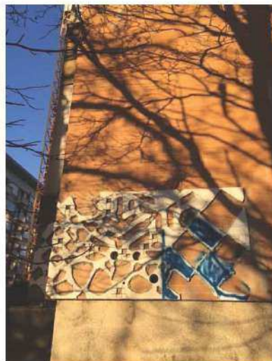
Estudo na fachada do edifício de escritórios Santo António © João Luís Marques, Dezembro 2017
