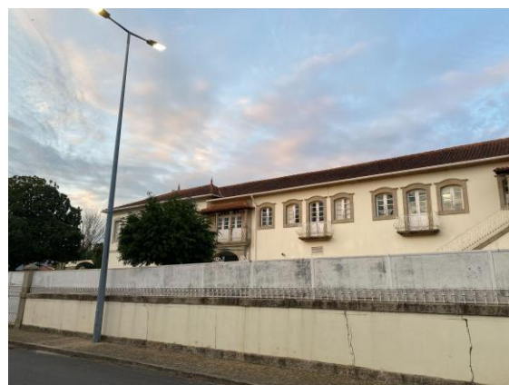
Figura 1: Vista exterior da ADR
