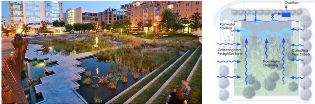
Figura 39: Bacia de biorretenção de Tanner Sprins Park, Portland, Oregon. E o seu funcionamento Fonte: (Consultants, s.d.),
