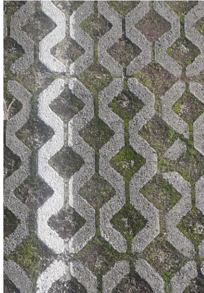
Figura 73: Pavimento em grelha de enrelvamento em betão. Fonte: Parque de estacionamento, Rua da Misericórdia, Matosinhos, da autora.
