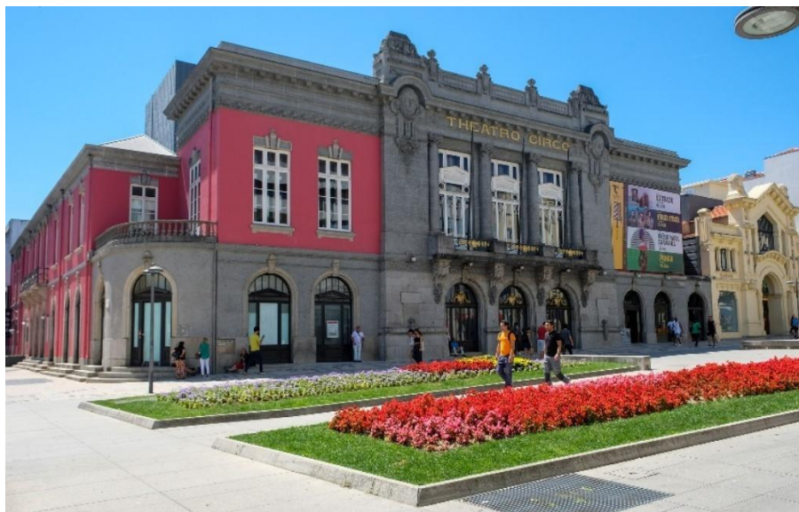
Figura 4.1 - Fachada do Theatro Circo em Braga [74].
