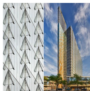
E15| Manitoba Hydro Place
