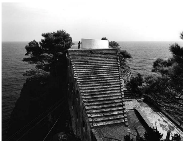
053| Escada da cobertura, Casa Malaparte, Punta Massulo, Capri.
