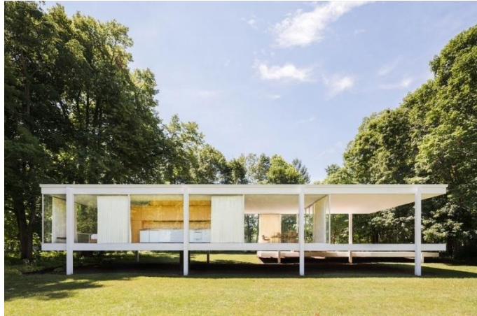
055| Mies van der Rohe, Casa Farnsworth , Illinois, (1945-1951).
