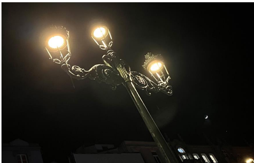
IMG. 90 - blindagem que impede a projecção de luz para o céu, evitando a poluição luminosa
