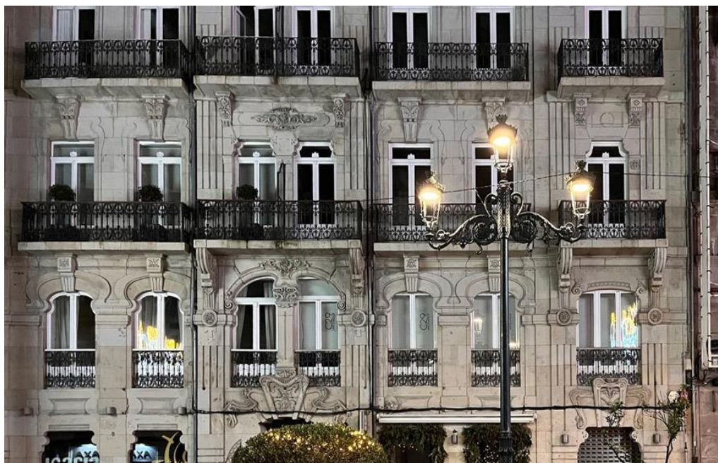
IMG. 89 - estética do mobiliário de iluminação urbana na Cidade de Vigo, adaptando a tecnologia LED
