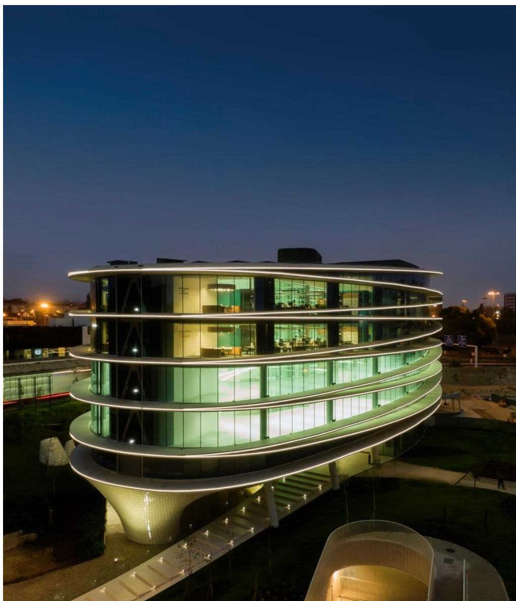
IMG. 111 - edifício Icon Douro I (GUERRA, 2022)
