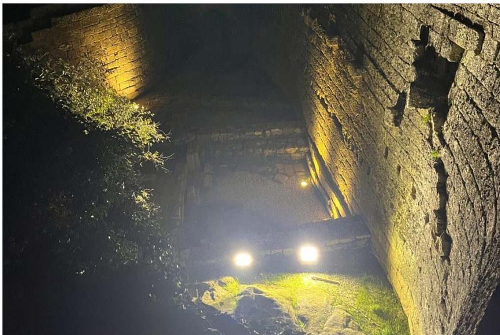
IMG. 74 - é visível o distinto tratamento luminoso para as estruturas no interior do castelo e a torre de menagem
