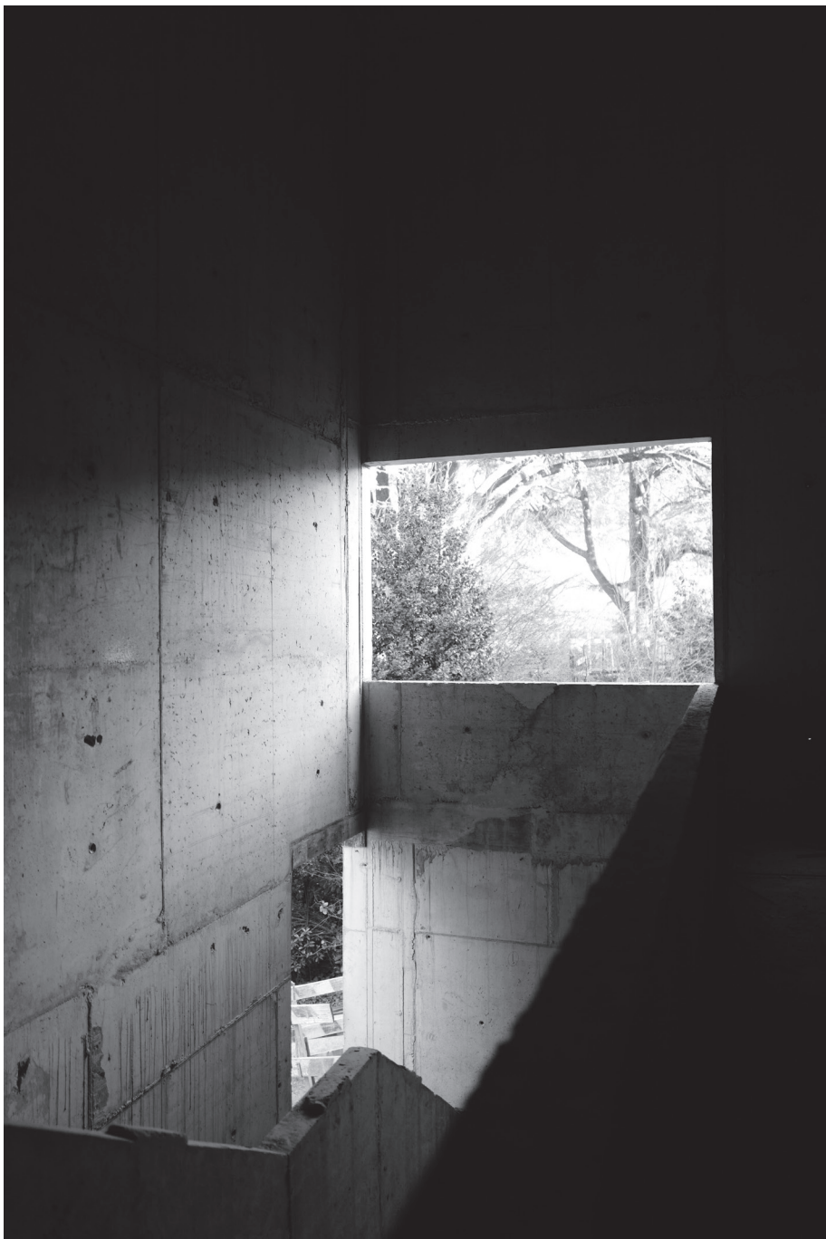
Fase de obra - caixa de escadas em toco
