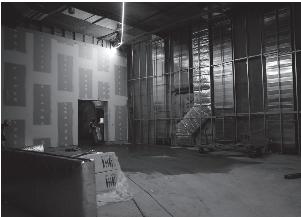
Fotos de obra - montagem das infraestruturas de ventilação na galeria
