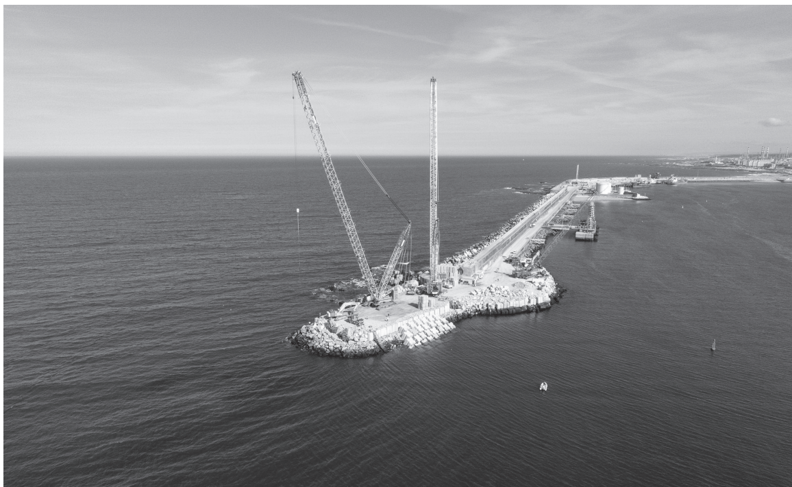
Fig. 09. Prolongamento do quebra-mar e proteção de Inverno
