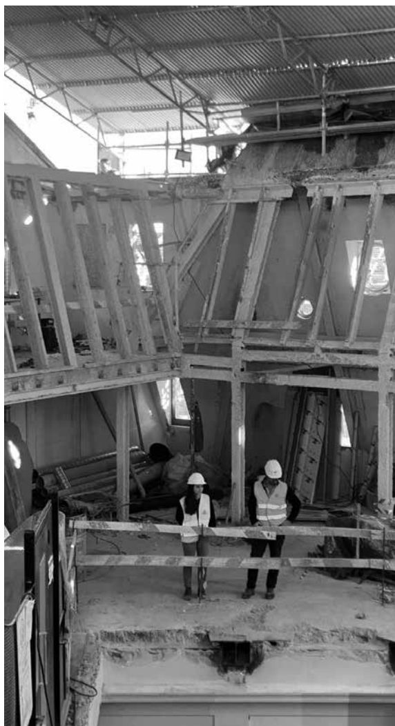
Fotografias da cobertura
