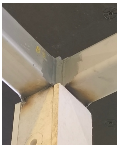
Figura 57 - Vista da ligação das vigas aos pilares soldada no módulo ensaiado
