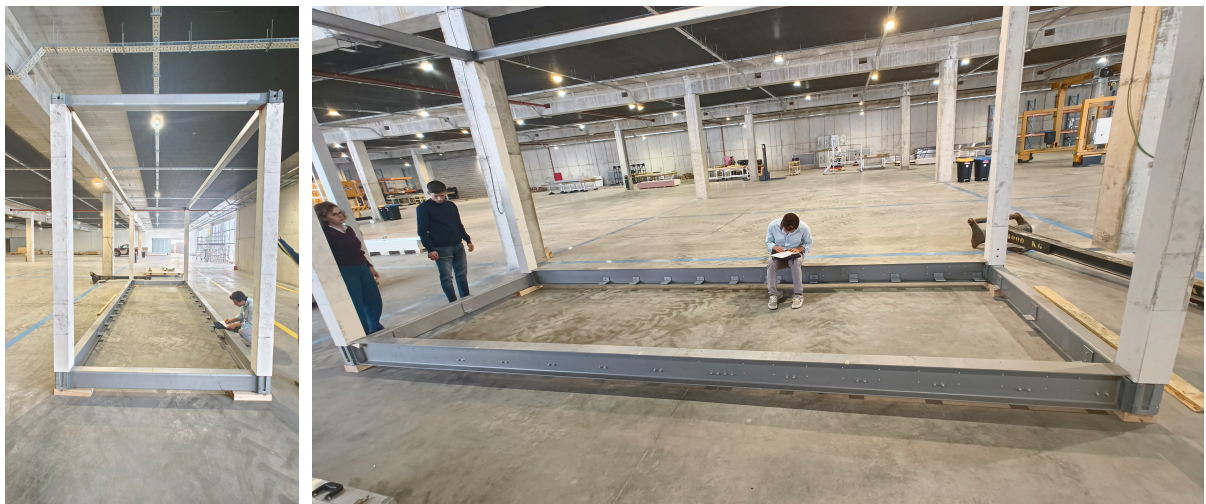
Figura 28 – Vista da estrutura metálica do módulo
