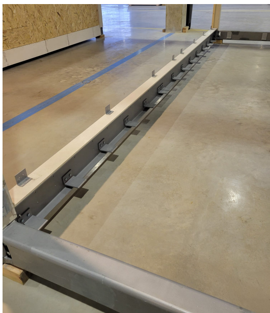
Figura 34 - Vista das cantoneiras aparafusadas no banzo do perfil IPE
