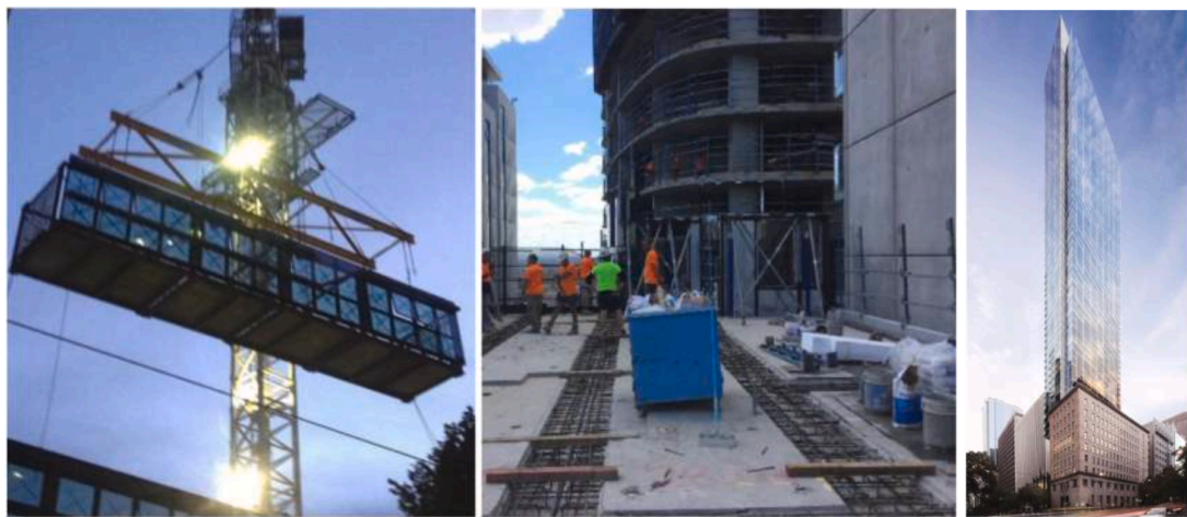
Figura 9 - Edifício Collins House: Módulo laje e fachada (à esquerda), preparação de Wet Joints (centro) e vista exterior do edifício Collins House (à direita) (Thai et al., 2020)
