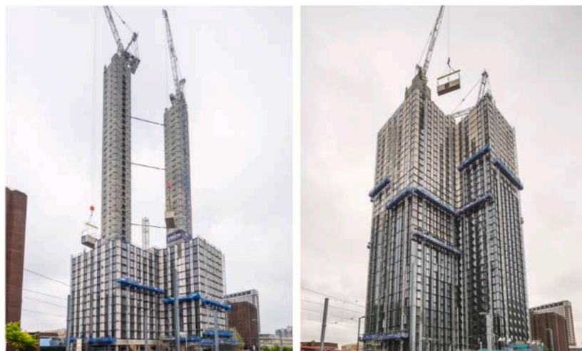
Figura 10 - Vista de duas fases construtivas da Torre Croydon (Thai et al., 2020)
