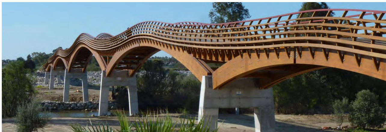
Figura 1. Pasarela sobre el río Guadalhorce
