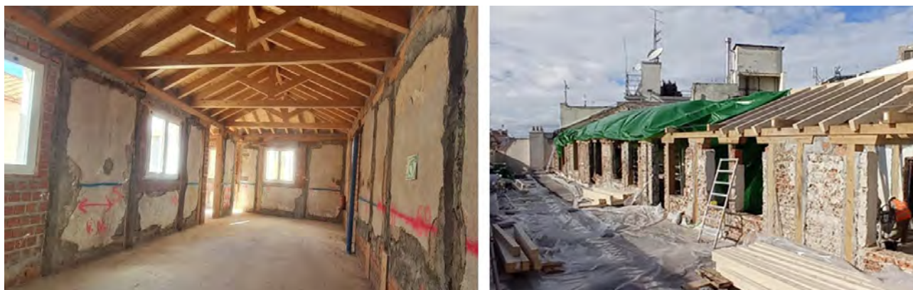
Figura 4. Izqda. Nueva cubierta de madera laminada del edificio. Fuente: Janet Calixto Roca. Dcha. Reparación de los pies derechos de la estructura entramada de madera con nuevas piezas en el ático. Fuente: Kalam. (2021)
