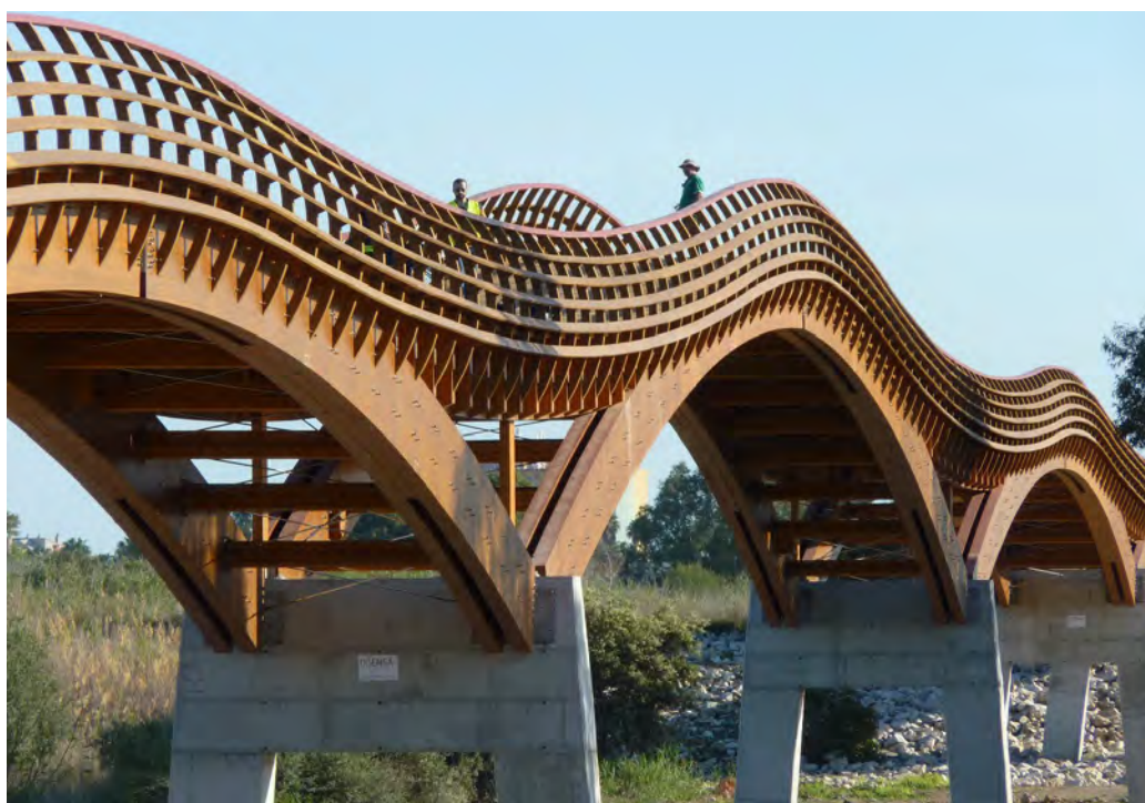
Figura 2. Realización de ensayos dinámicos sobre la pasarela previos a su inauguración
