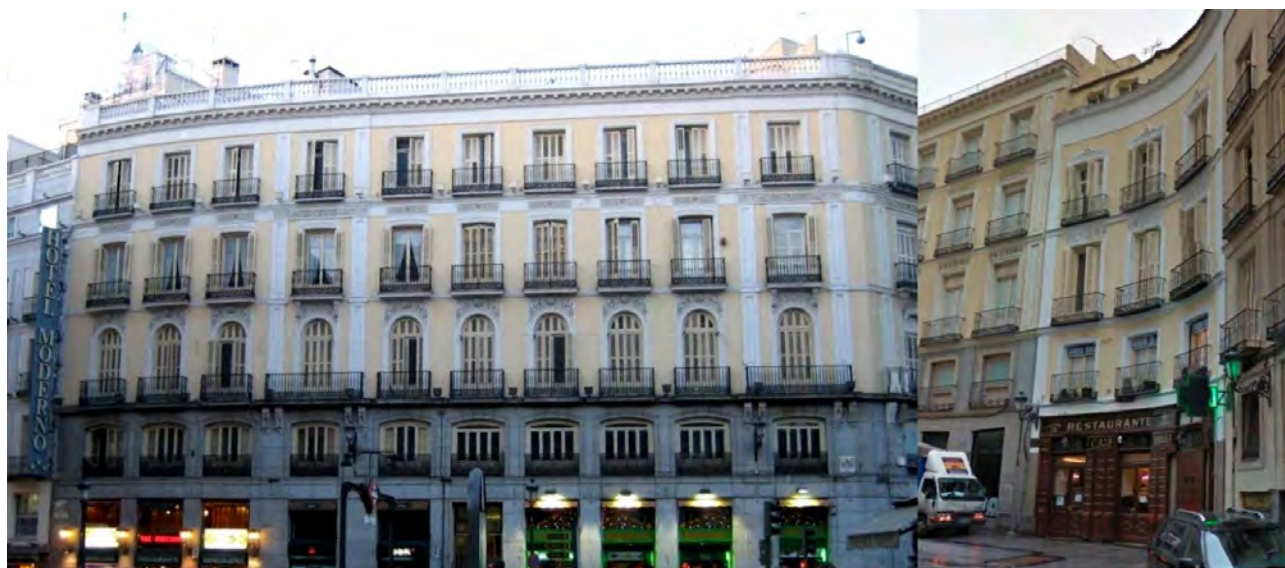
Figura 1. Izqda. Fachada del edificio de la Puerta del Sol nº 9. Dcha. Fachada desde calle Tetuán. Fuente: Janet Calixto Roca (2016).
