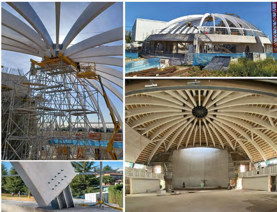
Figura 3 Imágenes del montaje de la obra
