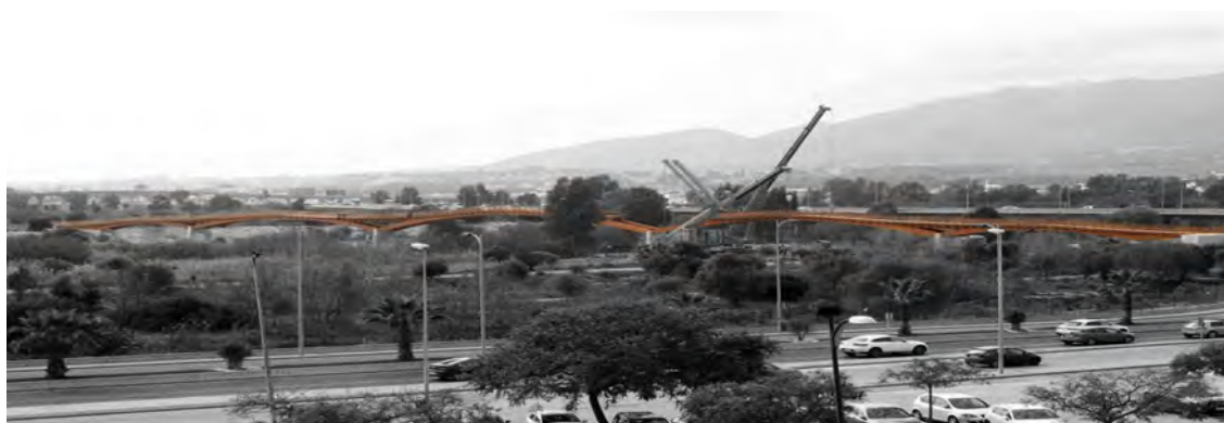
Figura 3. Montaje del tramo central
