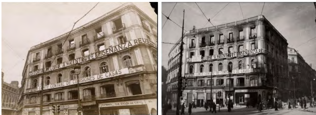
Figura 3. Bombardeo del edificio 10 de la Puerta del Sol, 1936. Fuente: BNE)
