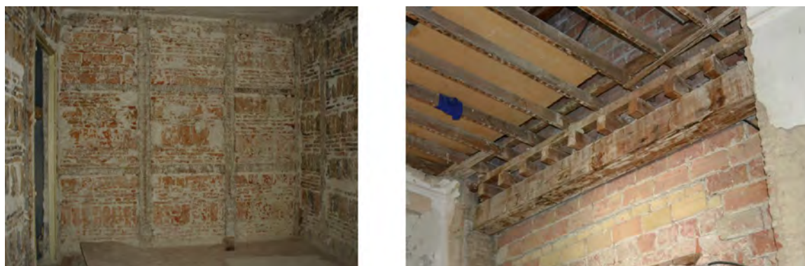
Figura 3. Muro Medianero. Izqda. Posada del Dragón, Cava Baja (Madrid). Fuente: Sonsoles González Rodrigo (2009). Dcha. Vivienda en C/ Nosquera 9 (Málaga). Fuente: M a Victoria Sierra Ramos (2021).
