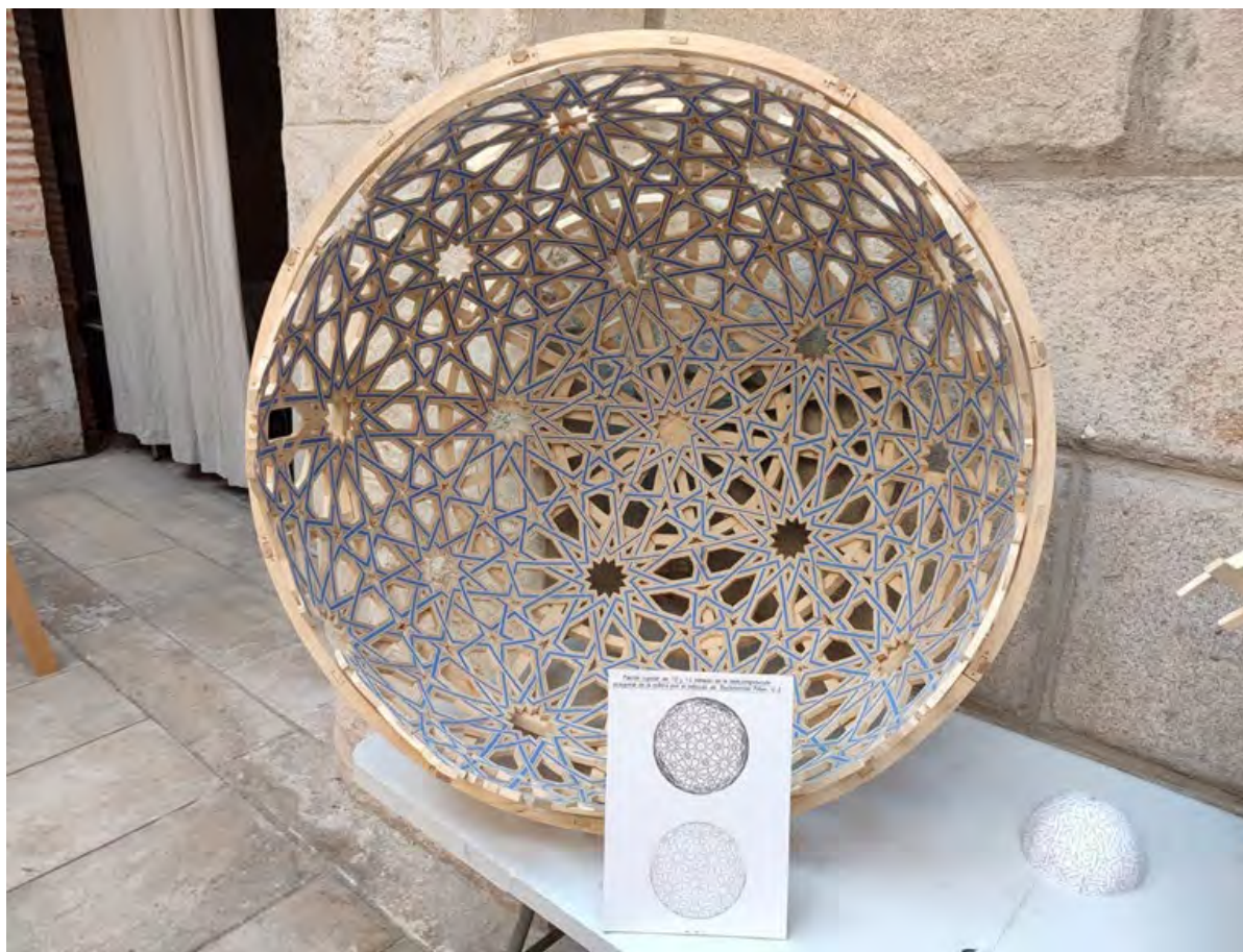
Figura 1. Exploración del modelo de una cúpula de madera de lazo hecha de ruedas de 12 y 10.
