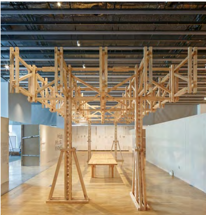
Figuras 2, 3. Amarar. Entramado bidireccional de celosías trianguladas. Detalle de conexión.
