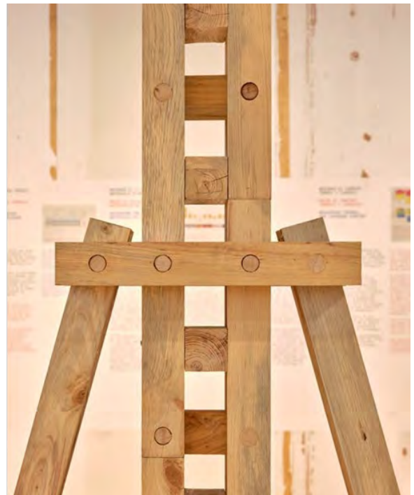
Figuras 2, 3. Amarar. Entramado bidireccional de celosías trianguladas. Detalle de conexión.
