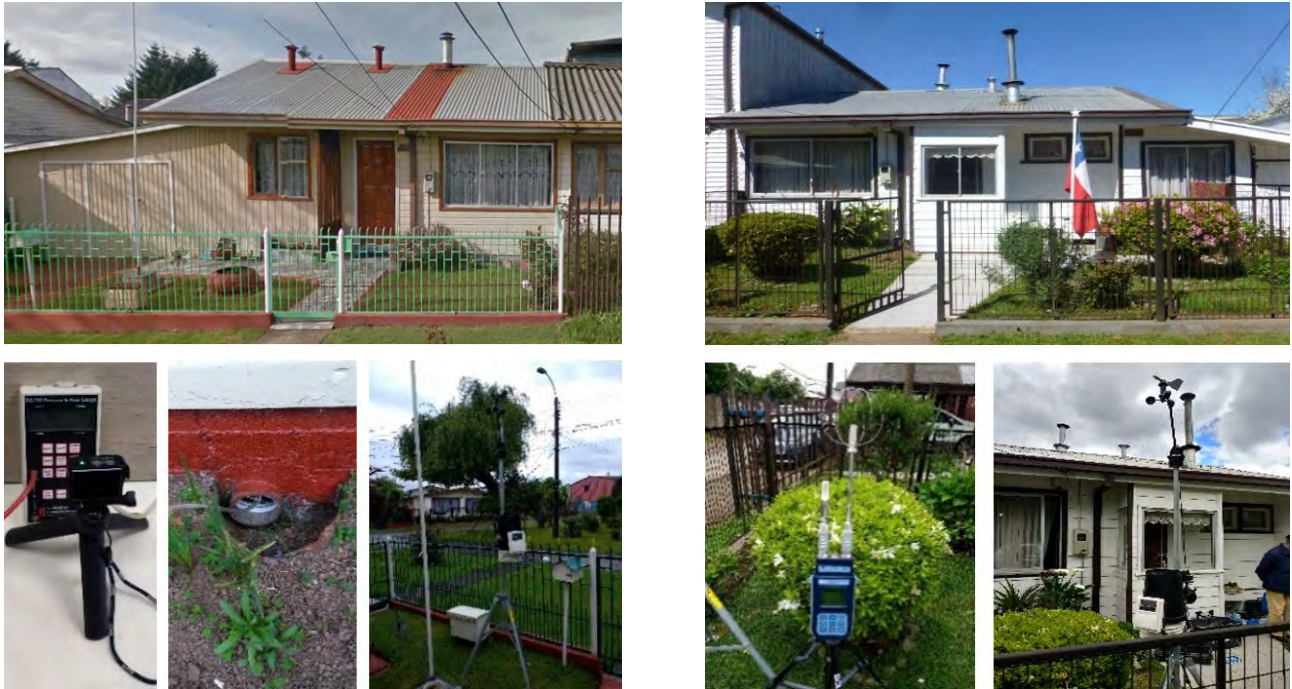
Figura 1: Ensayo in situ para determinar tasas de renovación de aire bajo piso. Vivienda 1 sin signos de hongos bajo piso, y Vivienda 2 con signos de hongos bajo piso
