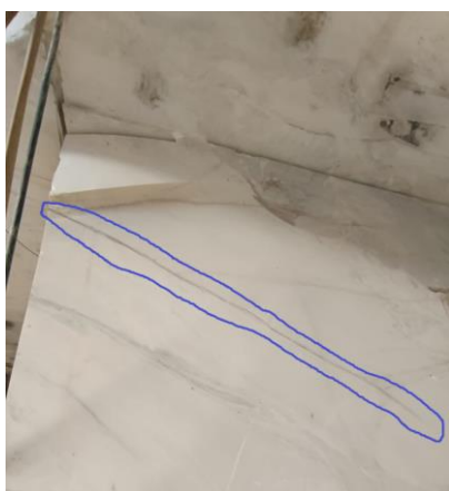
Figura 19 Presença de uma descontinuidade em rocha mármore
