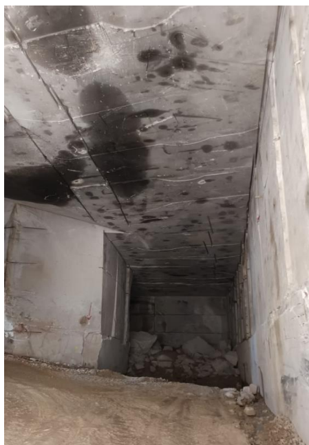
Figura 8 Exemplo da escavação subterrânea na Pedreira Del Rey
