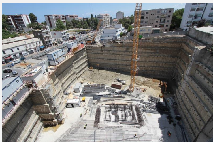
Figura 10 - Contenção de estacas moldadas secantes com 0,60 m de diâmetro ancoradas em 7 níveis na sede do Golf Bank, Argel, 2015
