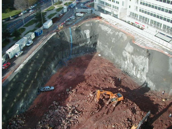
Figura 13 - Contenção com revestimento de betão projetado pregado no Parque de Estacionamento de Miraflores, 2000
