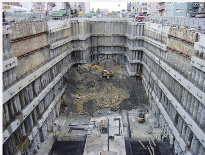
Figura 9 - Contenção de estacas moldadas com 0,60 m de diâmetro afastadas de 1,20 m ancoradas em 5 níveis de vigas de ancoragem na Estação do Metro de Moscavide, Lisboa, 2009
