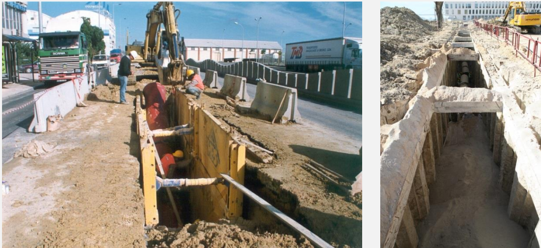
Figura 4 - Escavação de vala à custa de taludes
