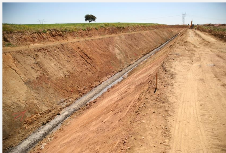
Figura 3 - Escavação de vala à custa de taludes
