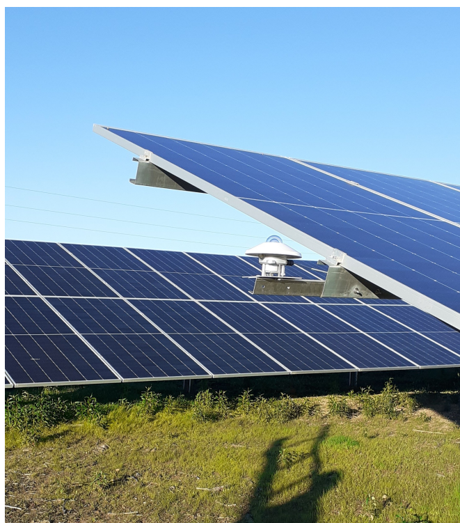
Figura 3.12: Piranómetro montado numa central fotovoltaica.
