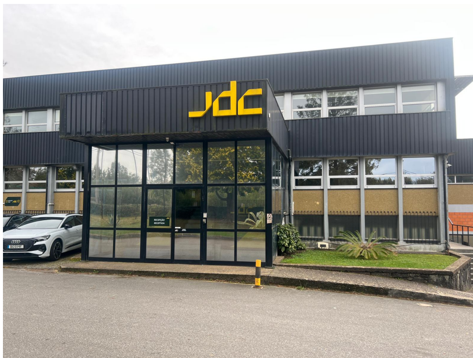
Figura 1.4: Instalações da Jayme da Costa no Porto.
