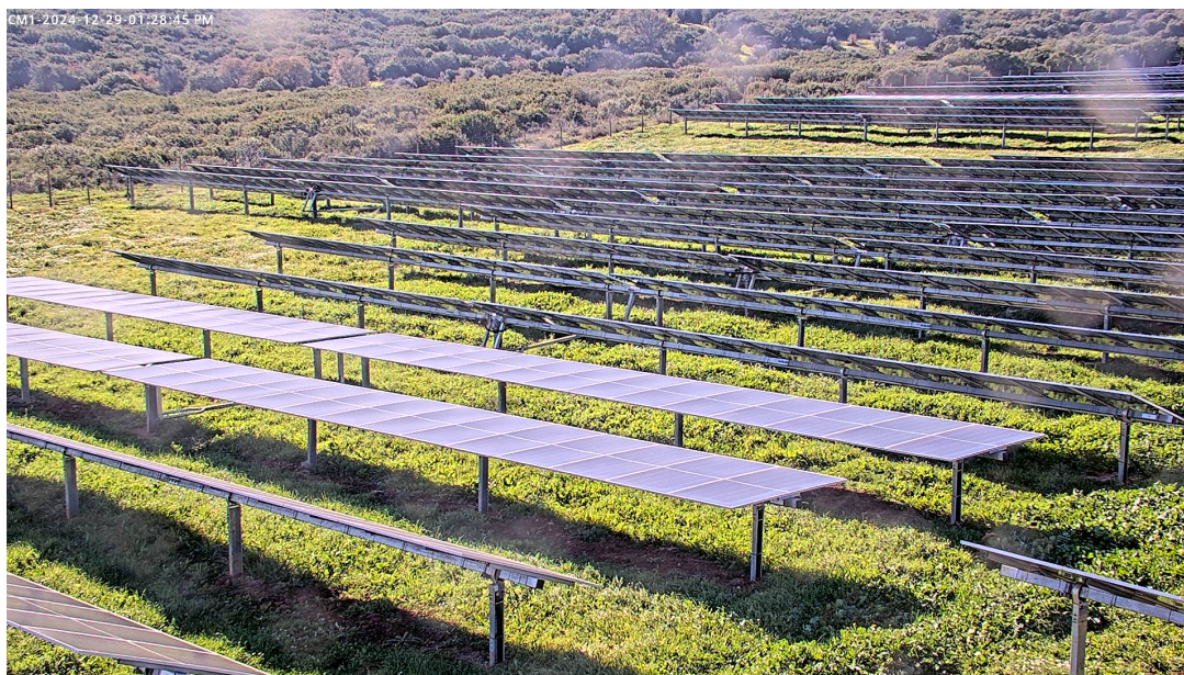
Figura 3.8: Instalação de módulos solares equipados com trackers numa central fotovoltaica.
