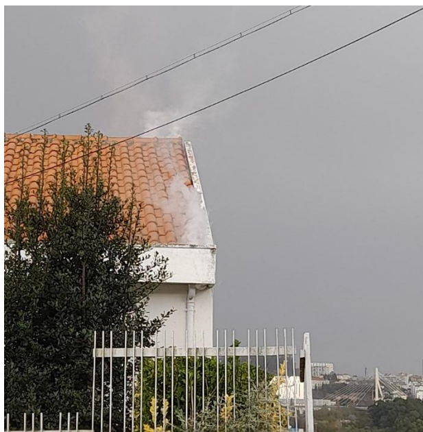
Figura 11 - Exemplo de uma inspeção com injeção de fumos, na zona de Gondomar, a 25 de outubro de 2024.
