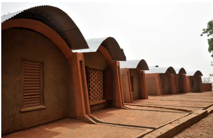
Figura 26: Residência de Professores em Gando, Burkina Faso
