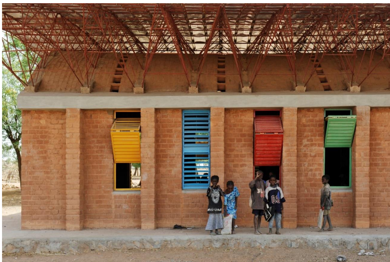
Figura 20: Escola primaria de Gando - Burkina Faso
