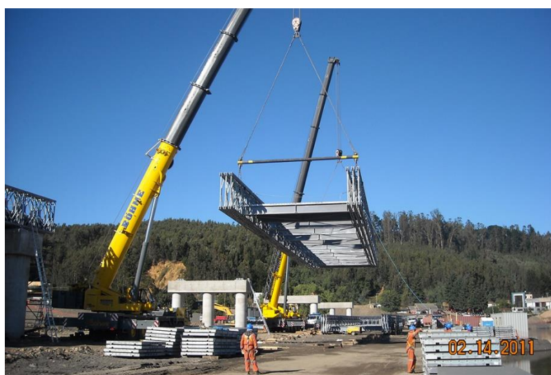
Fig. 2.32 – Instalação com grua (Acrow Corporation of America 2023d)
