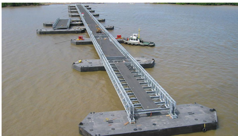
Fig. 2.20 – Ponte do tipo Bailey com múltiplos vãos (Mabey Bridge, 2023c)
