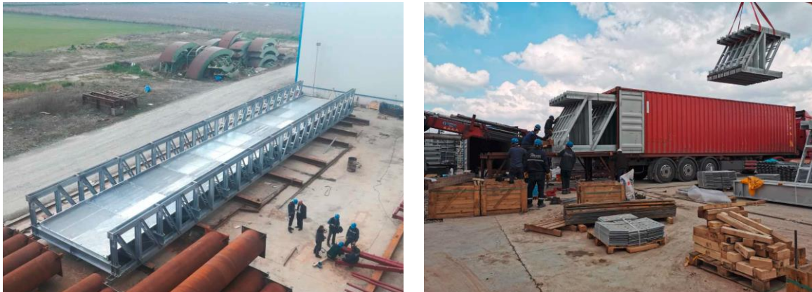
Fig. 2.22 – Construção em fábrica e contentorização de uma ponte modular (André et al. 2019)
