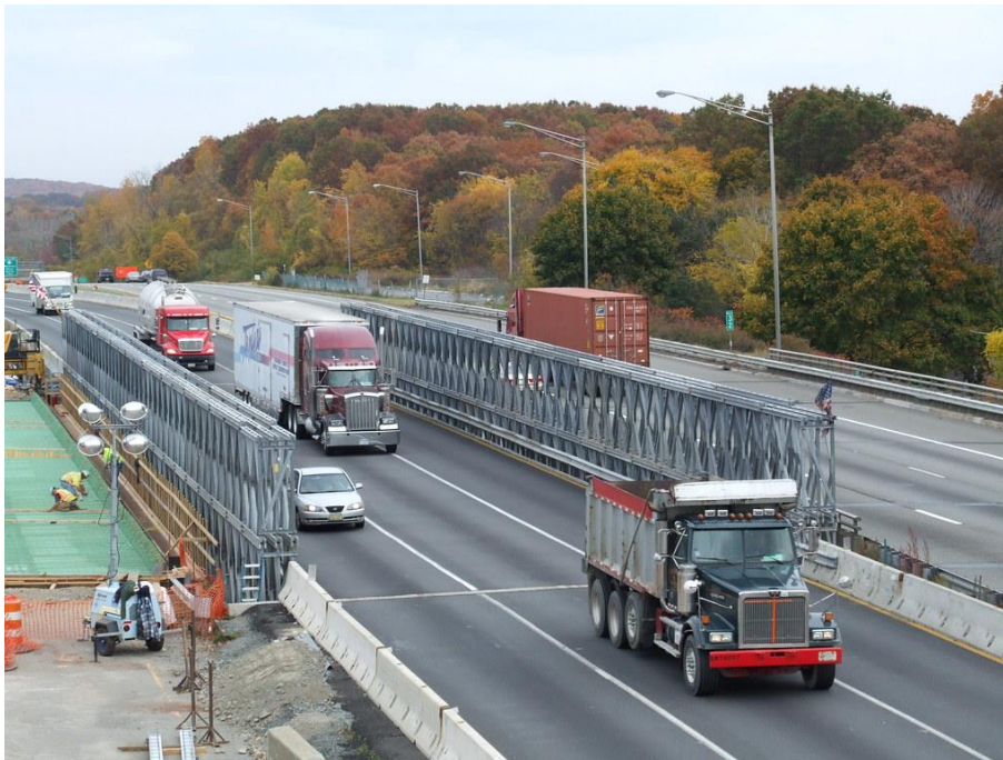
Fig. 2.17 – Ponte do tipo Bailey com três planos e dois níveis de painéis (Washington State Department of Transportation 2013)
