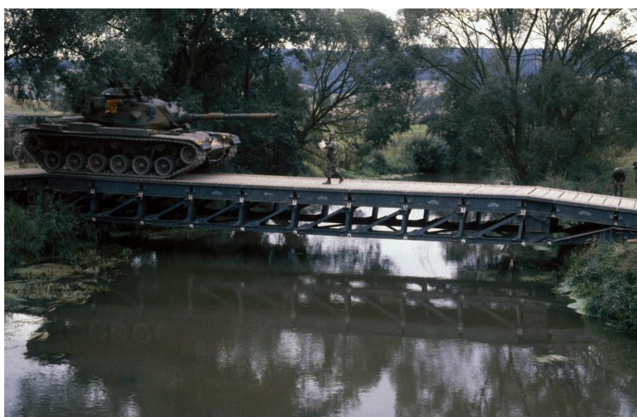
Fig. 2.11 – Ponte MGB com treliça inferior de reforço (U.S. National Archives and Records Administration 1983)
