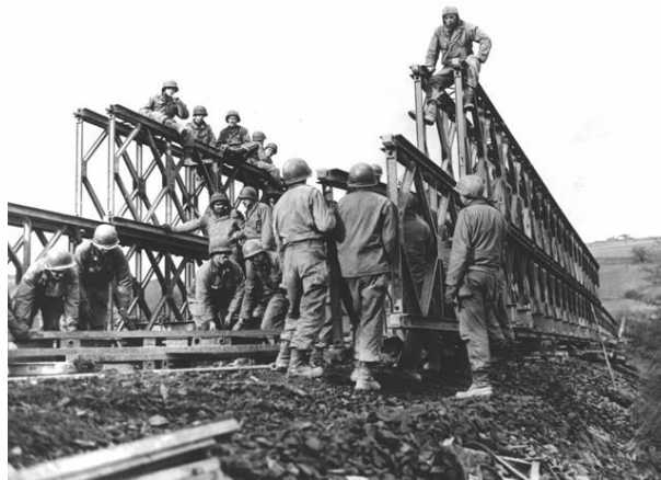
Fig. 2.13 – Instalação de uma ponte Bailey (Engineering and Technology 2018)
