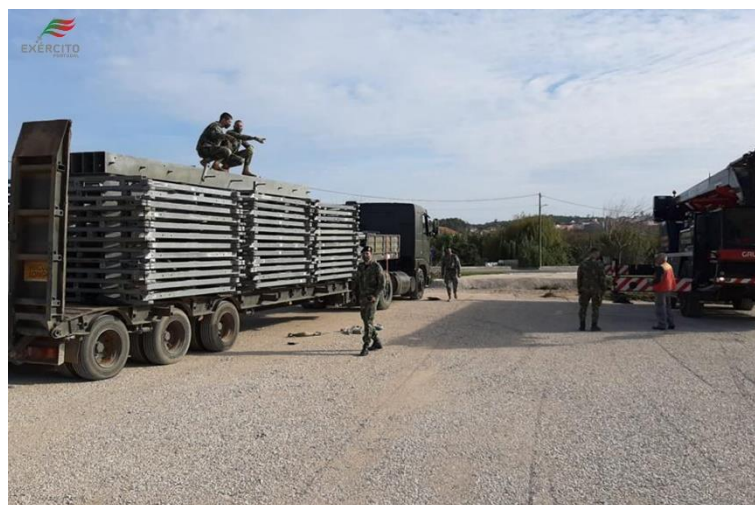
Fig. 2.29 – Estaleiro para montagem de uma ponte modular (Exército Português 2020)
