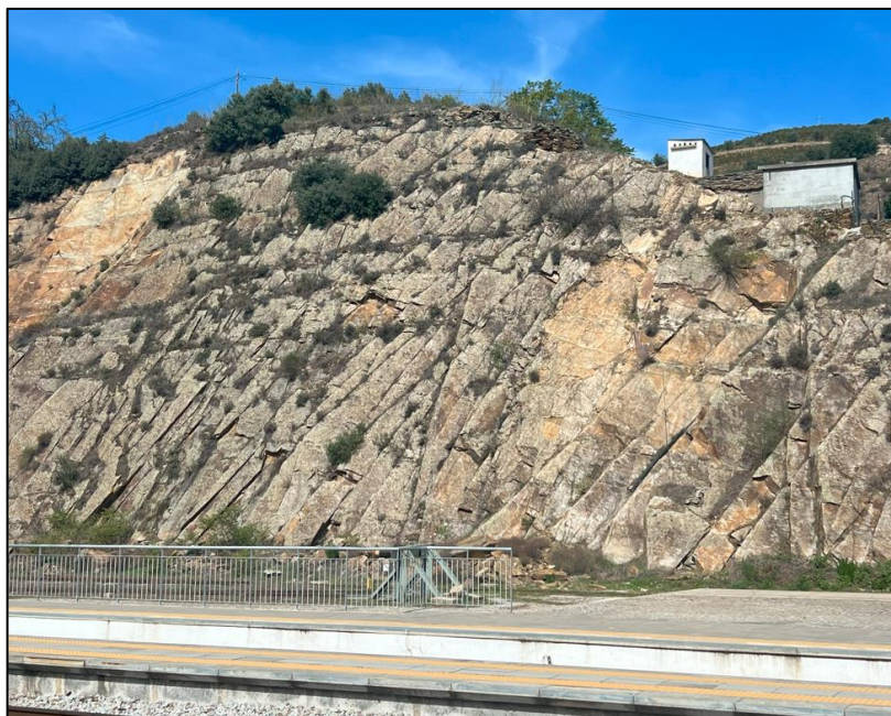
Fig. 3 - Descontinuidades do talude ao lado da estação do Tua, no rio Douro.
