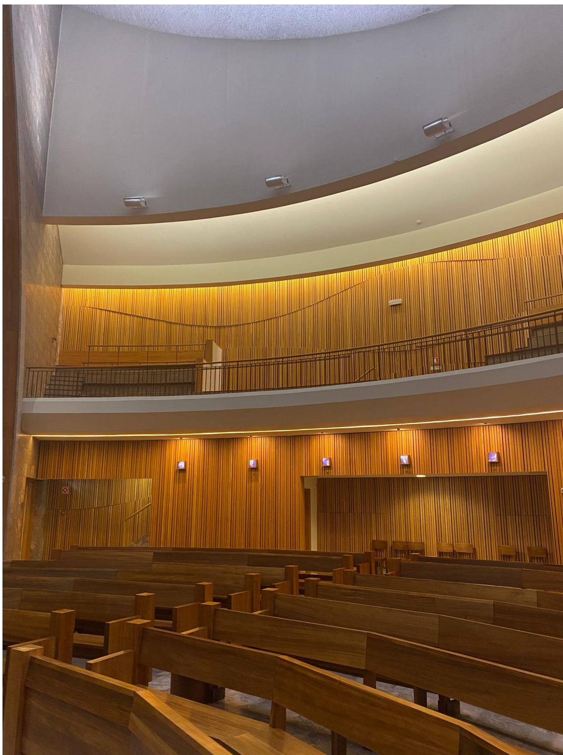
Fig. 4.15 – Ressoadores agrupados (ripas de madeira com absorvente colocadas nas paredes da igreja de Nossa Senhora dos Navegantes [foto do autor].
