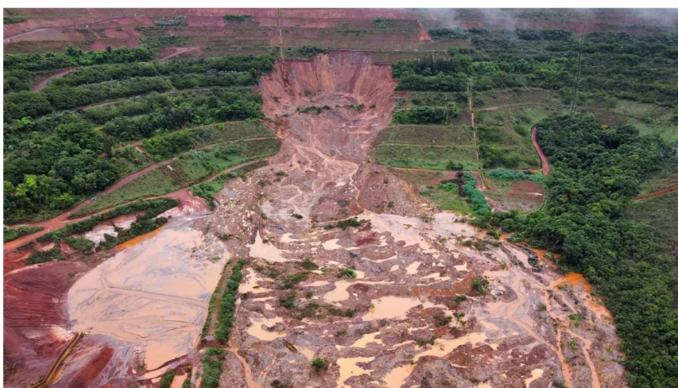
Fig. 16 – Vista aérea da rotura da pilha de rejeitados da Mina de Pau Branco no Brasil da Vallourec (adaptado de https://www1.folha.uol.com.br ).
