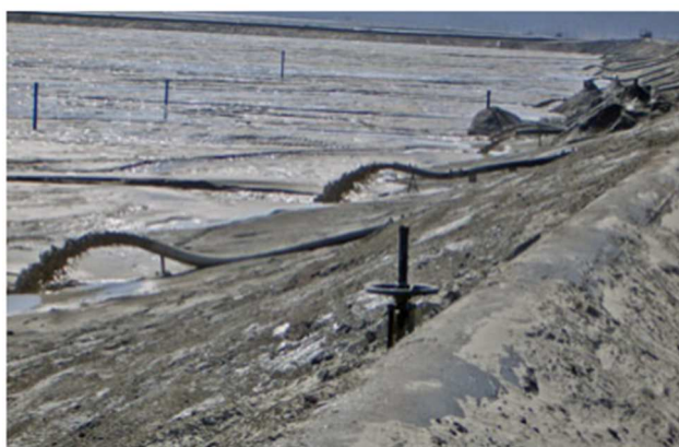
Fig. 5 – Spigot em pontos múltiplos (adaptado de https://www.tailings.info/basics/tailings.htm ).
