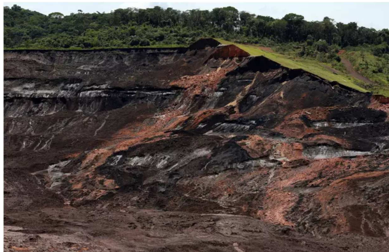
Fig. 48 – Liquefação estática na Barragem do Brumadinho (adaptado de www.terra.com.br ).
