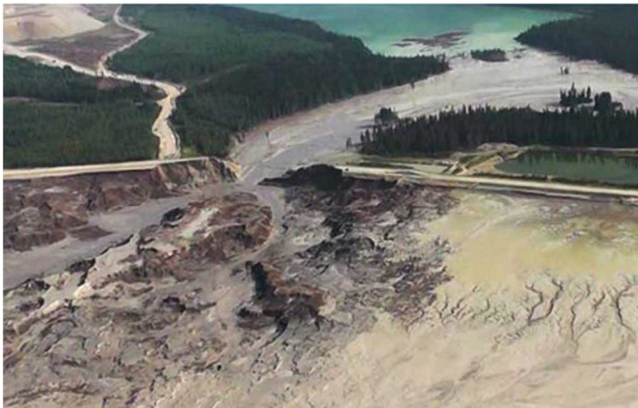
Fig. 18 – Rotura na Barragem em Mount Polley, no Canadá (adaptado de https://multinationales.org ).
