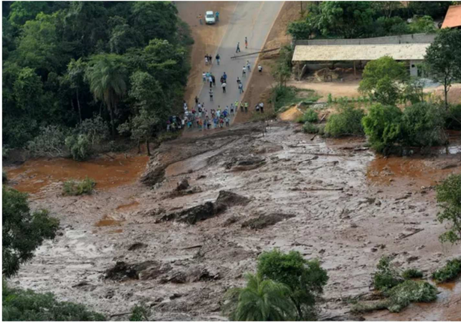
Fig. 17 – Vista aérea da rotura da Barragem do Feijão em Brumadinho no Brasil (adaptado de https://epocanegocios.globo.com/ ).
