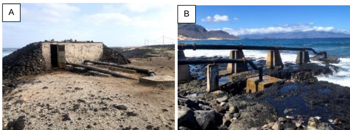
Fig. 7 - A: Estação de captação de água. B: Zona de captação de água. (fotos do autor)
