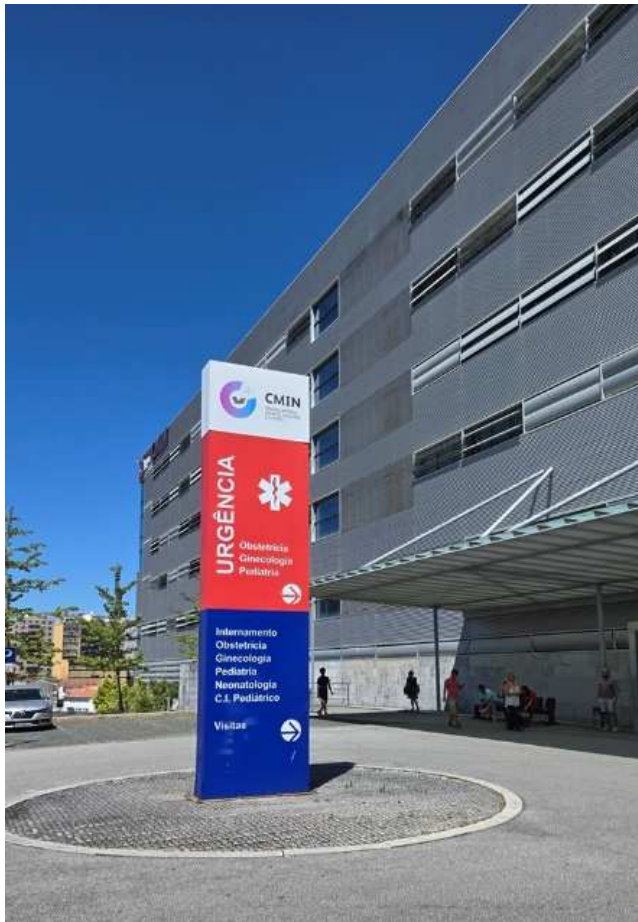
Imagem 1 – Fachada de CMIN, 2024. Fonte: Autora
