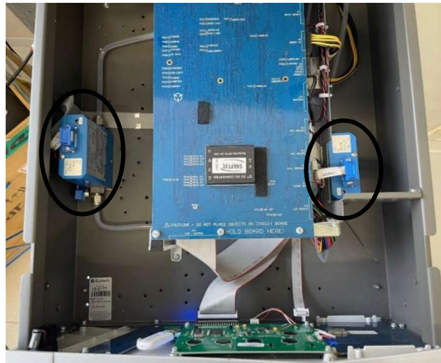
Figura 16 – Parte da vista interior do diluidor dinâmico. Destacam-se os controladores associados ao gás de diluição (lado esquerdo) e o controlador associado ao gás de span (lado direito)
