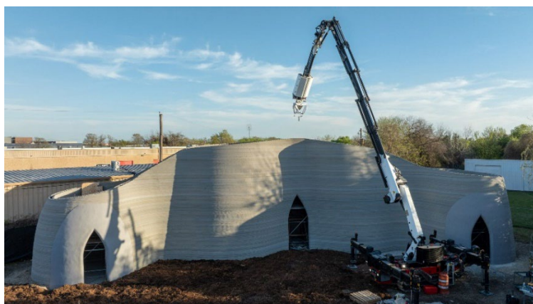
Figura 38 – Impressora Phoenix em uso (ICON 2024)
