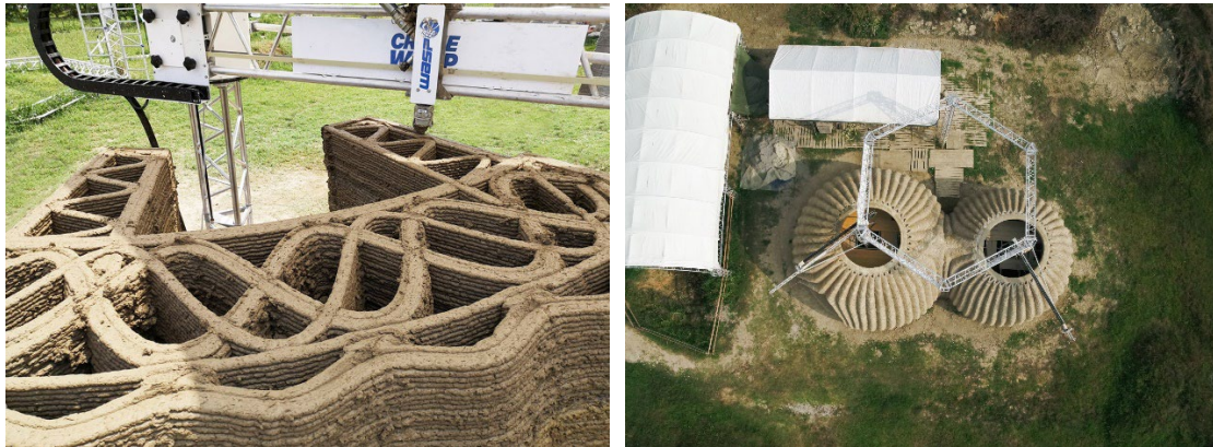
Figura 43 e 44 – Protótipo TECLA sendo impresso pela impressora WASP Crane (Italdron 2021)
