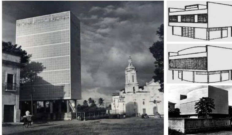
Figura 110 – A caixa de água de Olinda, Brasil à esquerda; e o Pavilhão de Verificação de Óbitos, à direita. Arquiteto Luiz Nunes (Brazil Builds 1943)
