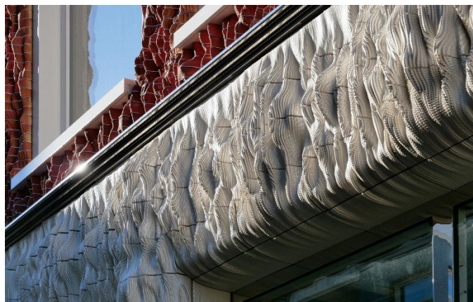
Figura 31 – Detalhes do efeito orgânico e dinâmico da fachada (Studio RAP 2014)
