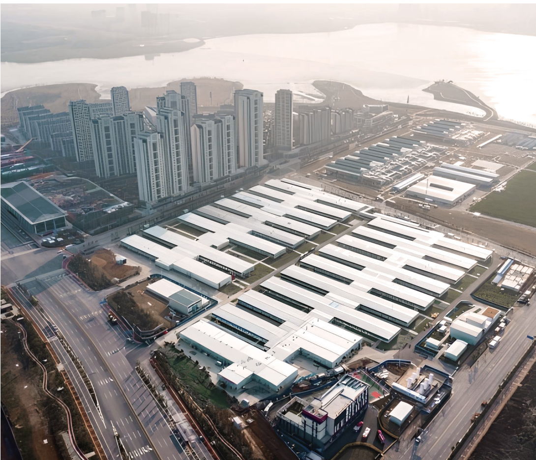
▲ FIG.10: Hospital emergencial Huo Shanshan em construção
