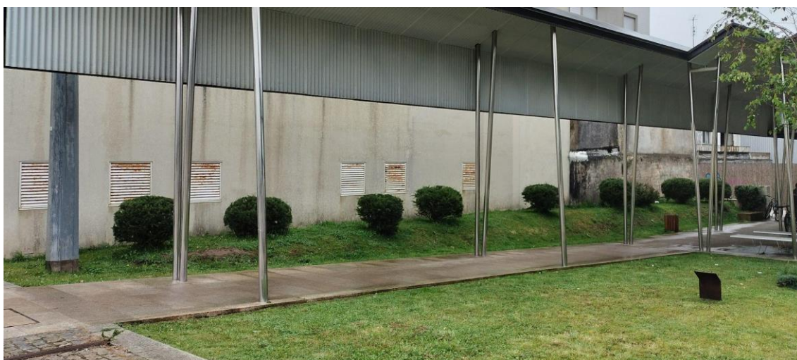
Figura 10: Área de intervenção (Fonte: Autor)
