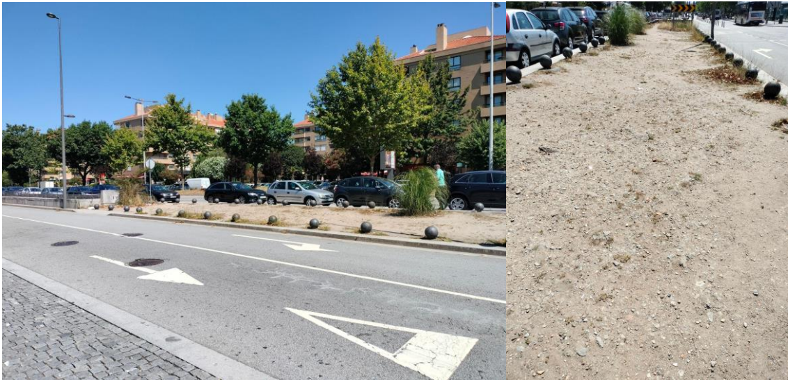
Figura 12: Área de intervenção (Fonte: Autor)
