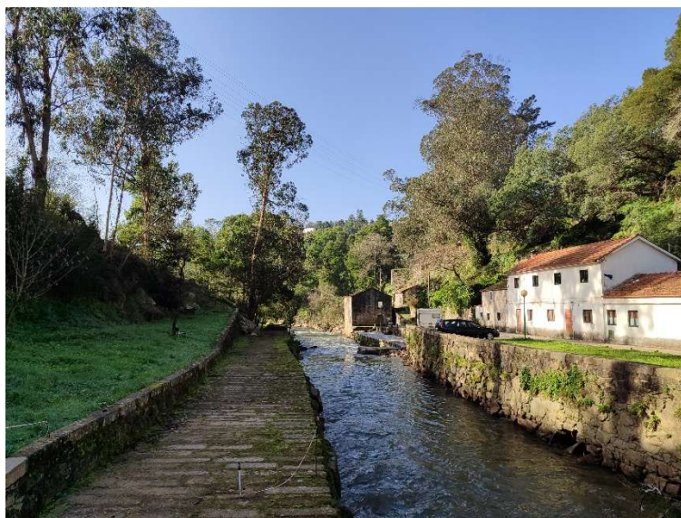
Figura 11 - Ponte do Carro (panorâmica)
