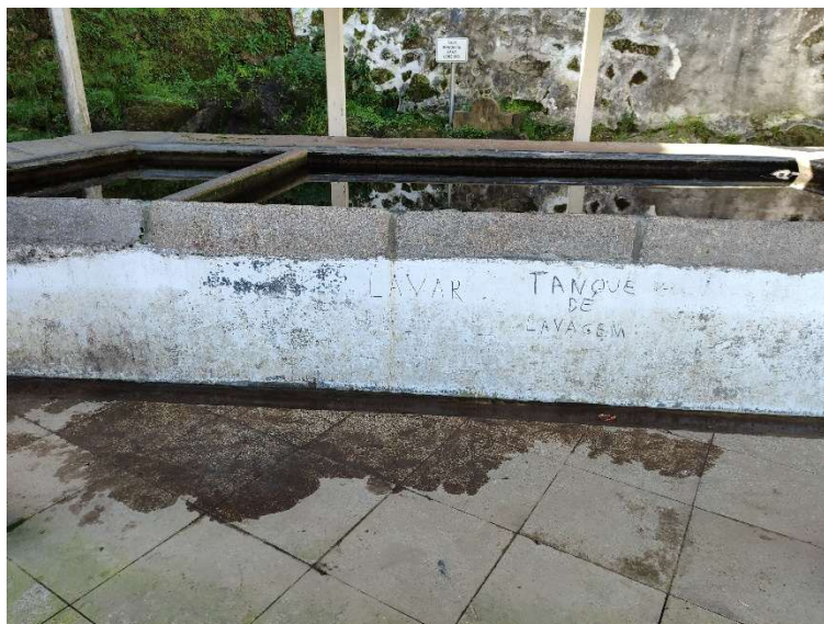
Figura 36- Tanque dos lavadouros (instrução "tanque de lavagem")
