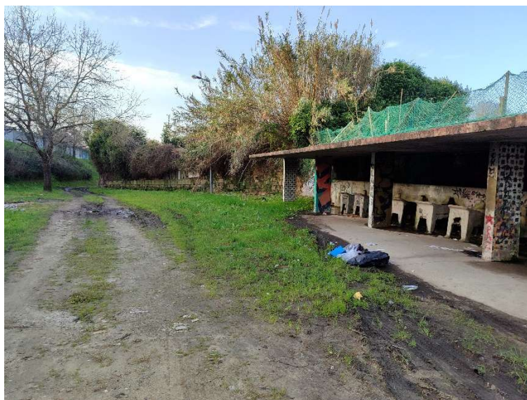
Figura 46 - Tanque Mosteiro de Bouças (acesso)
