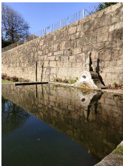
Figura 30 - Quinta da Conceição (tanque grande)
