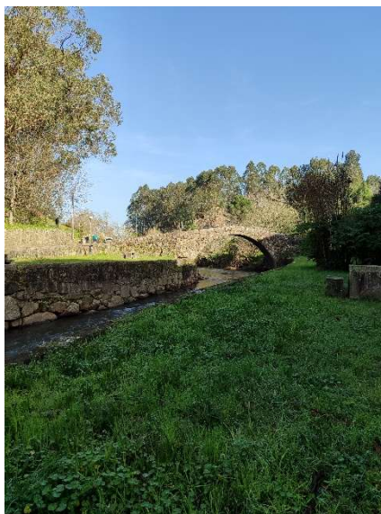
Figura 12 - Ponte do carro (ponte)
