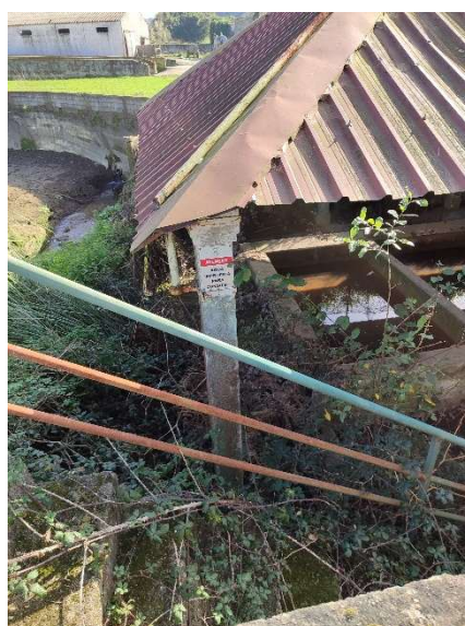
Figura 48 - Tanque Largo da Capela - Esposade
