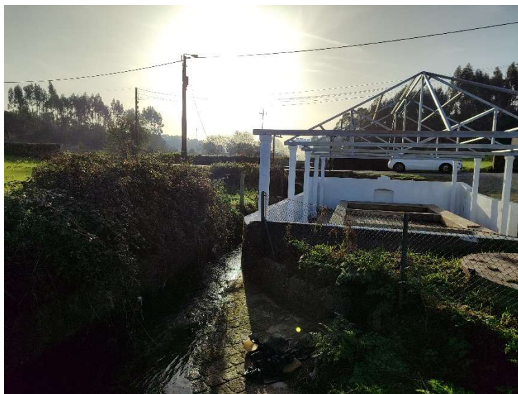
Figura 50 - Tanque do Paiço (ribeiro)
