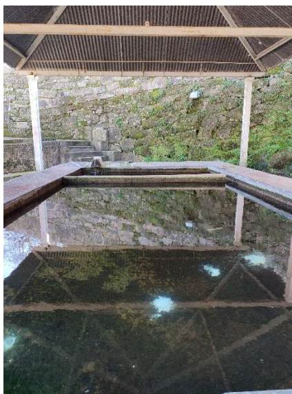
Figura 32 - Tanque dos lavadouros
