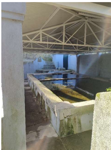
Figura 60 Tanque Vinha da Bouça (pormenor pedra de lavagem)
