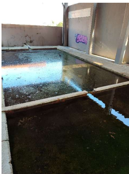
Figura 7 - Fonte da Cacheira (pormenor separador do tanque)
