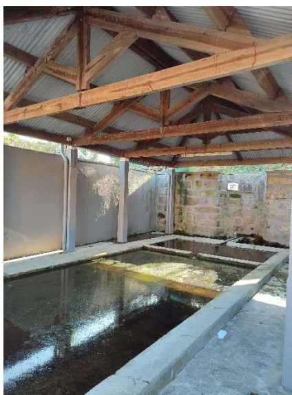
Figura 5 - Fonte da Cacheira (tanque e fonte)
