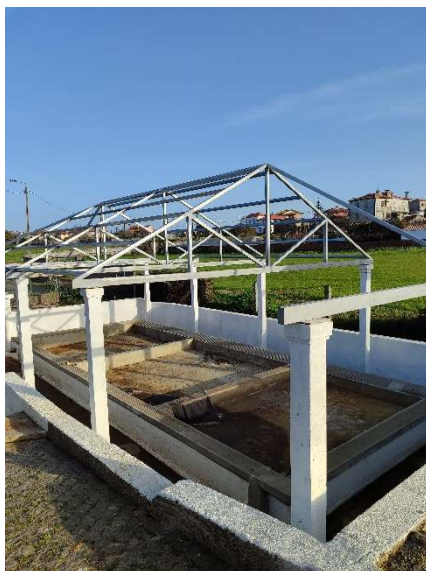
Figura 52 - Tanque do Paço (panorâmica)
