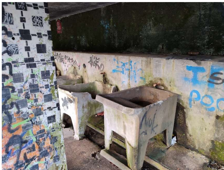
Figura 47 - Tanque Mosteiro de Bouças (pormenor tanques)
