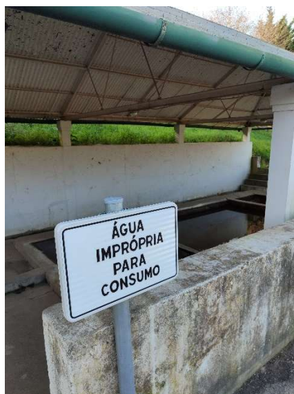
Figura 43 - Tanque Rio da Aldeia (pormenor placa informativa)
