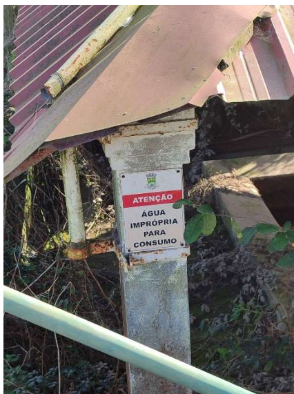
Figura 49 - Tanque Largo da Capela - Esposade (pormenor placa informativa)
