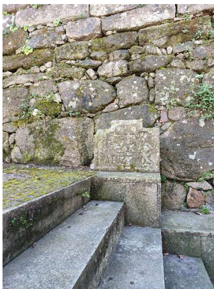
Figura 33 - Tanque dos lavadouros (pormenor placa Matozinhos)
