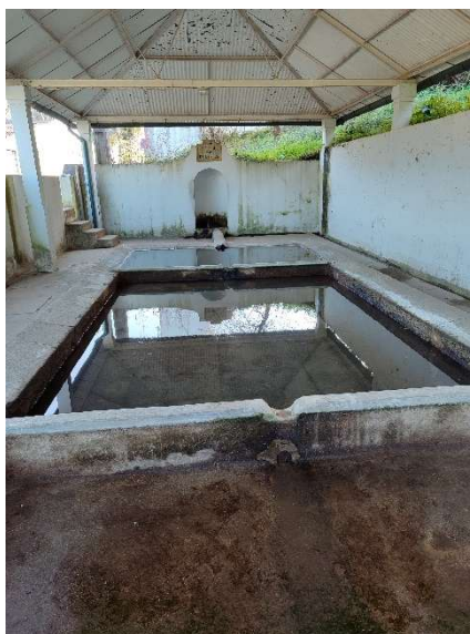
Figura 41 - Tanque Rio da Aldeia (tanque e fonte)
