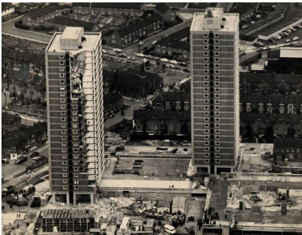
Fig. 5 – Colapso do edifício “Ronan Point”, Londres, 1968 [7]
