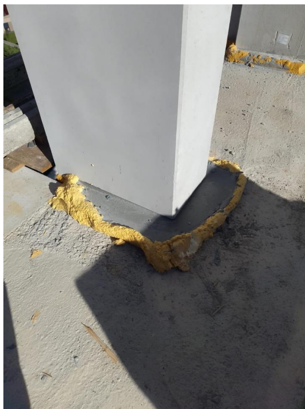
Fig. 45 – Selagem pilares prefabricados
