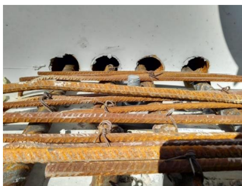
Fig. 57 – Armadura de cintagem num pilar
