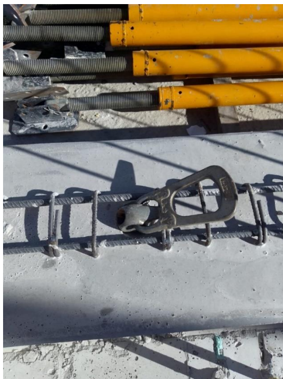
Fig. 32 - Pega para movimentação da peça numa viga
