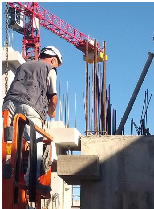
Fig. 50 – Montagem Viga prefabricada (ligação com parede betonada in situ)
