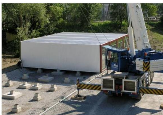
Fig. 12 – Ligação dos módulos à fundação [3]
