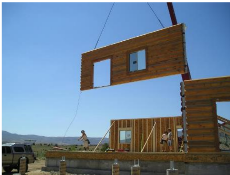
Fig. 14 – Montagem de painel de fachada em madeira [3]
