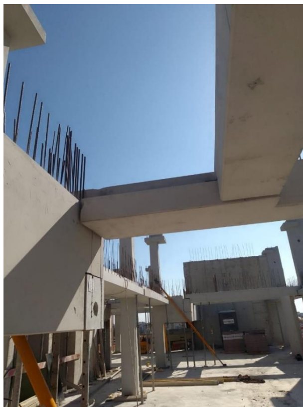
Fig. 64 - Limpeza e Organização da obra
