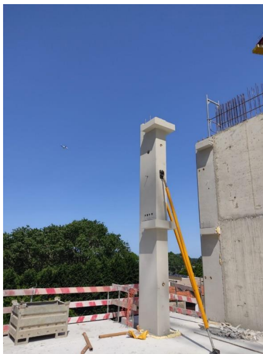
Fig. 44 – Escoramento Pilar prefabricado
