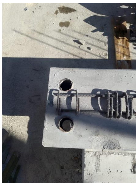
Fig. 47 – Bainhas corrugadas em viga prefabricada
