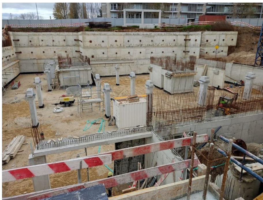
Fig. 41 – Arranque pilares prefabricados
