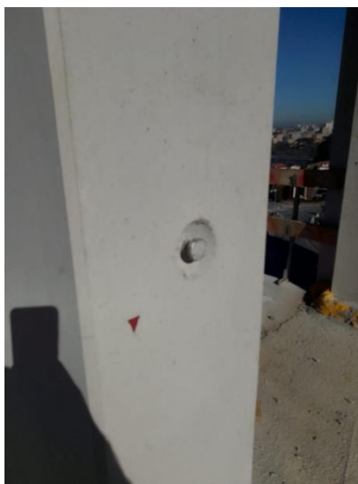
Fig. 30 - Prego de fixação (pilar)
