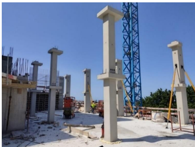
Fig. 65 – Acabamento dos elementos de betão prefabricado
