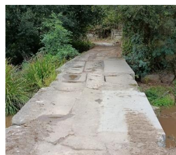
Figura 51. Ponte "restaurada" (Fonte: Autoria própria, 2024)
