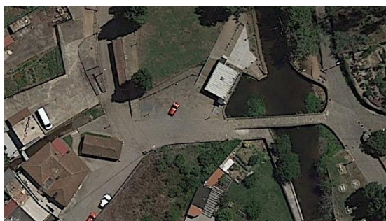
Figura 29. Vista topo do alinhamento Ponte/Capela - existente
