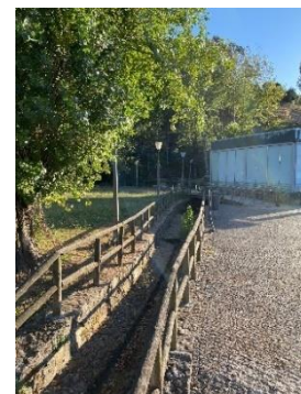
Figura 16. Linha de água murada (Fonte: Autoria própria, 2024)
