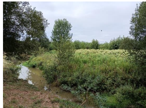
Figura 54. Obstrução do caudal do rio (Fonte: Autoria própria, 2024)
