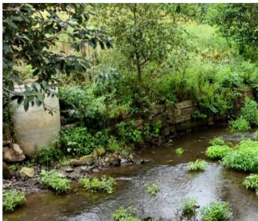
Figura 49. Conduta de saneamento e muro de contenção degradado (Fonte: Autoria própria, 2024)
