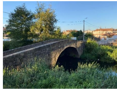
Figura 15. Ponte de S. Lázaro (Fonte: Autoria própria, 2024)
