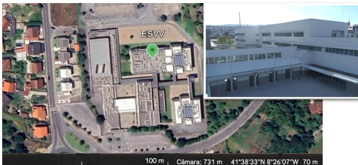
Figura 2 - Vista aérea e fotografia da Escola Secundária de Vila Verde
