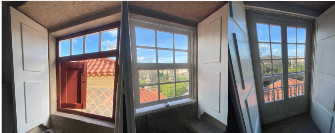
Figura 4 – Perspetiva das diferentes tipologias de janelas da reserva da cerâmica e vidros. © Inês Senra, 2024.
