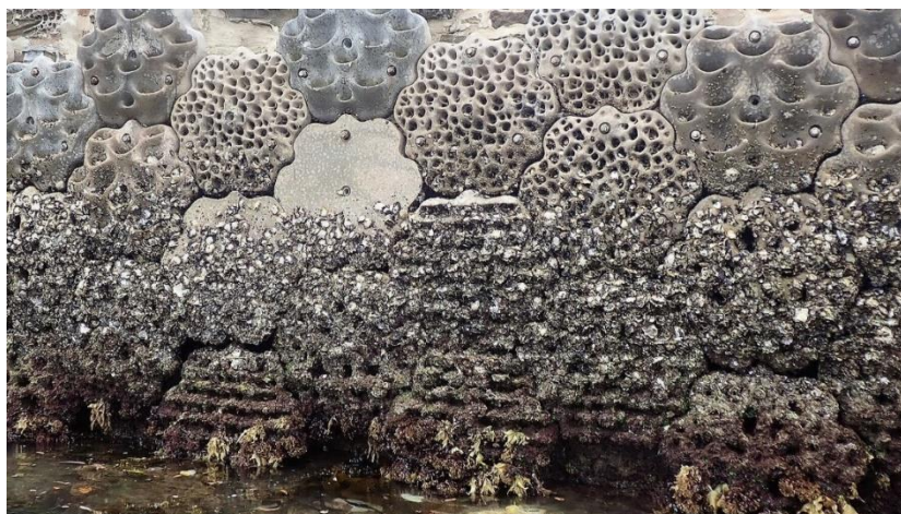
Figura 27. Resultados demonstrativos da instalação dos painéis Living Seawalls (Reef Design Lab & Sydney institute of marine science, 2024).
