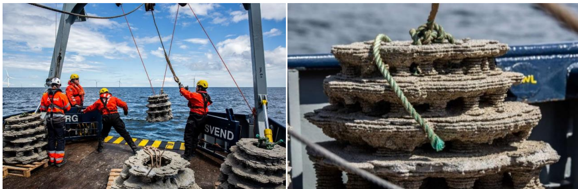
Figura 37. Processo de instalação dos recifes artificiais no Grande Mar do Norte (Ørsted & WWF, 2022).
