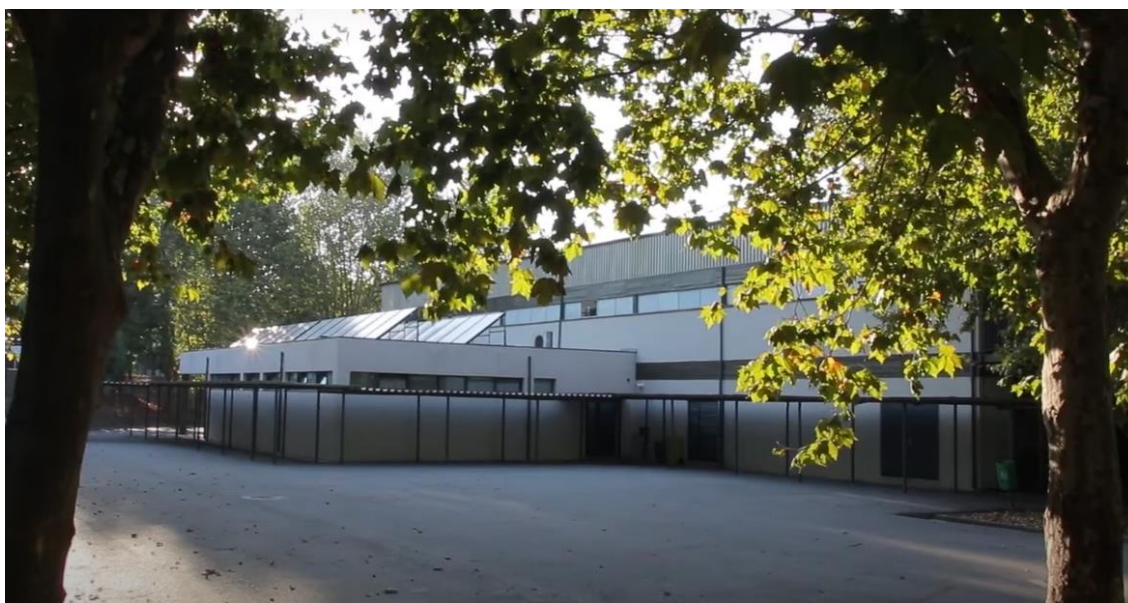
Figura 2 - Espaço Exterior do Pavilhão de Educação Física
